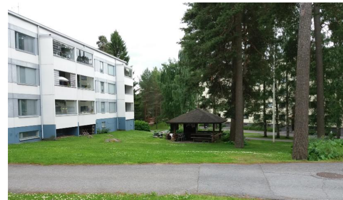
Piha-alue C-D rakennuksen edessä.
