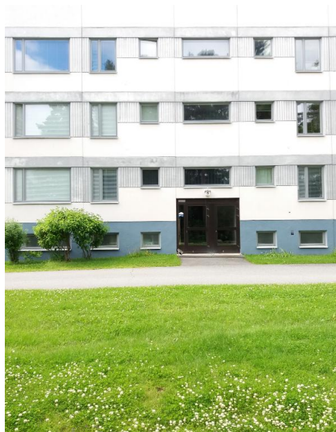
Raiskionkatu 5, detalji julkisivusta
