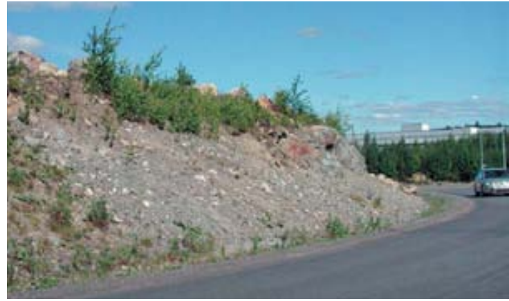
Kuva 5. Voimakkaat maa- ja kallioleikkaukset ovat tyypillisiä louhoksen muuttuvassa maisemassa sekä ramppien ja teollisuusalueen voimakkaasti rakennetussa ympäristössä. Täyttöjen ja leikkausten luiskatuilla alueilla kasvillisuuden hoito on hankalaa.
