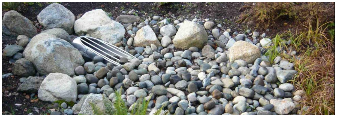
Kuva 15. Hulevesiviemärin purkuputken yhteyteen rakennettu eroosiosuojaus. 13
