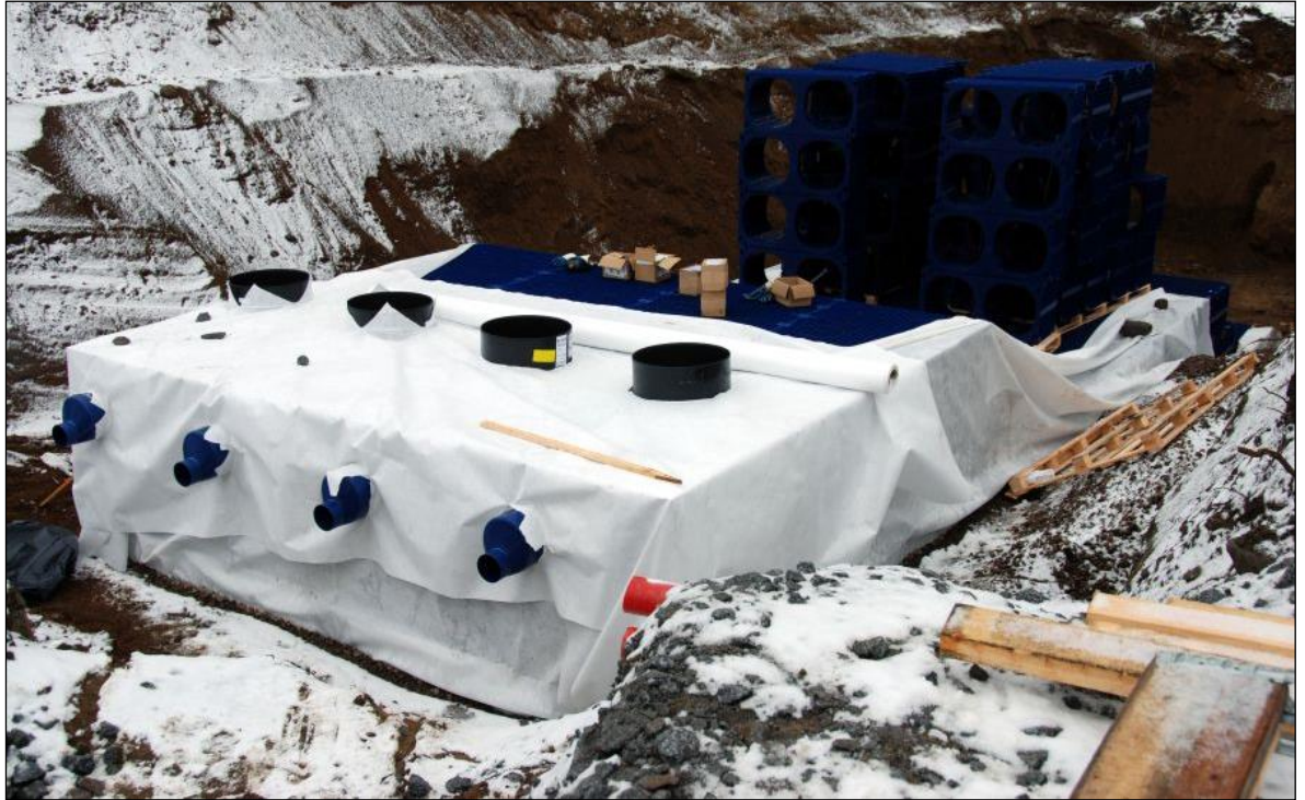
Kuva 11. Maanalaisen viivytystilavuudeltaan 300 m 3 kennoston rakentamista Tampereen Tykkitiekkadulla.
