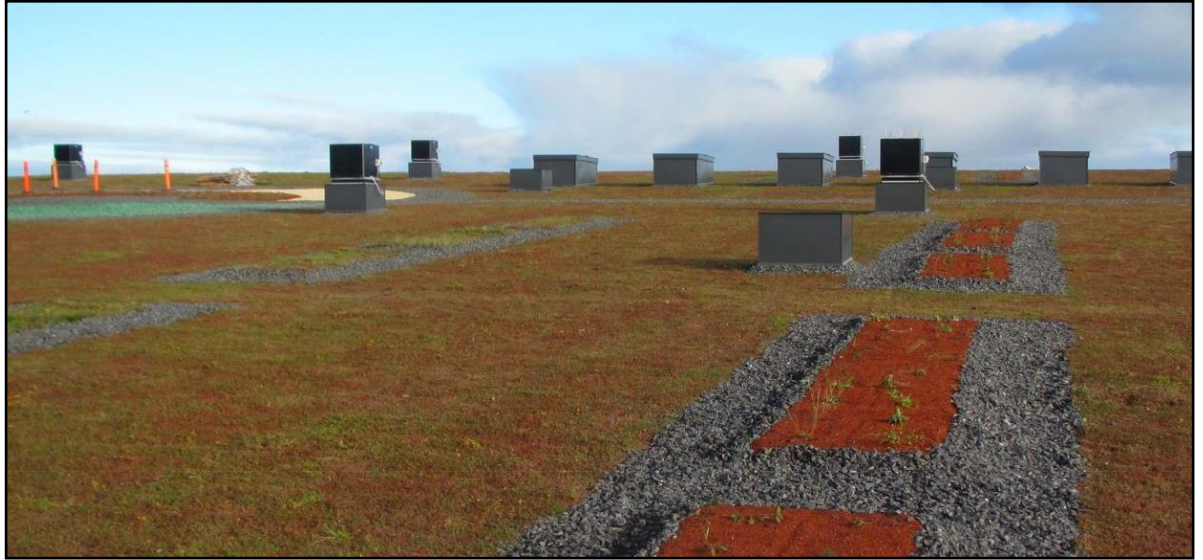
Kuva 8. Suomen suurin ja pohjoisin viherkatto valmistui Ouluun vuonna 2012. Ruskon Jätekeskuksen lajitteluareenan (LARE) sammal-maksaruohokaton pinta-ala on 3600 m 2 . 10
