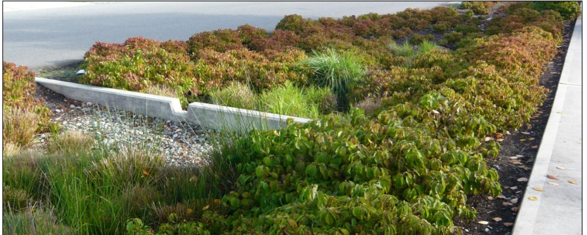
Kuva 12. Katualueen viherpainanne, johon on istutettu kasvillisuutta ja rakennettu virtausta hidastavia pohjapatoja. 9
