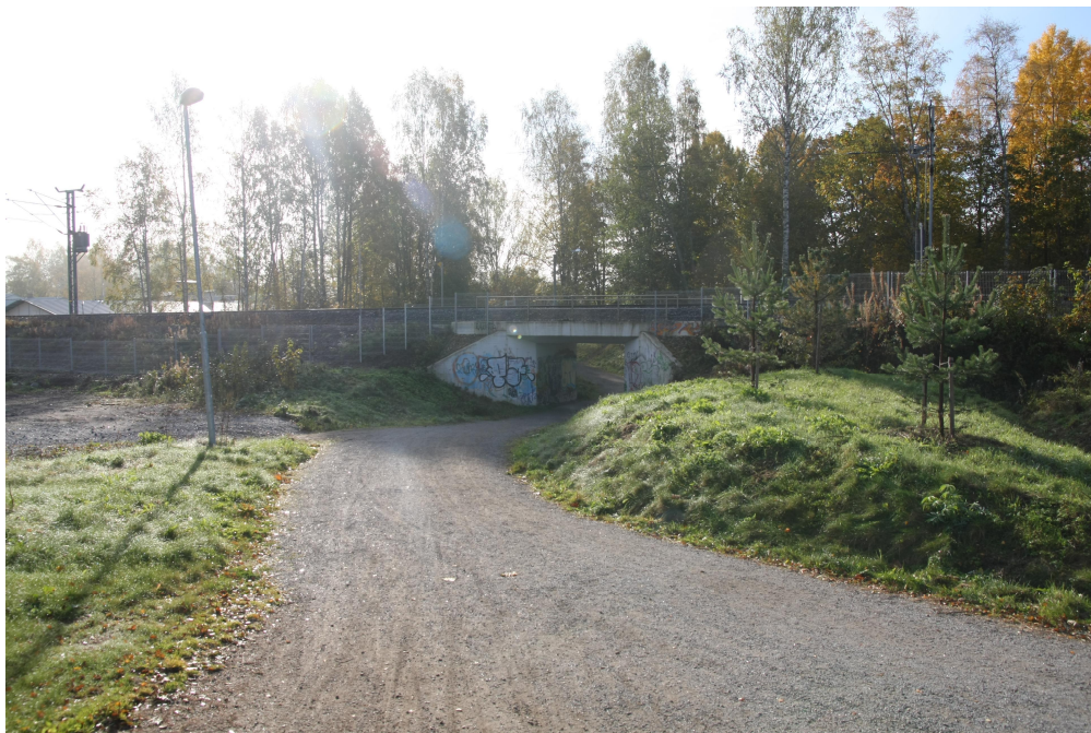
Kuva 7. Km 196+252 Vanamon alikäytävä radan pohjoispuolelta kuvattuna
