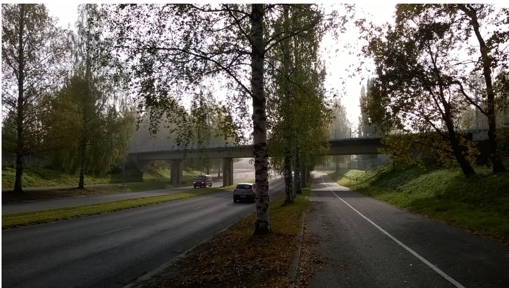
Kuva 6. Km 196+057 Tesoman alikulkusilta radan pohjoispuolelta kuvattuna
