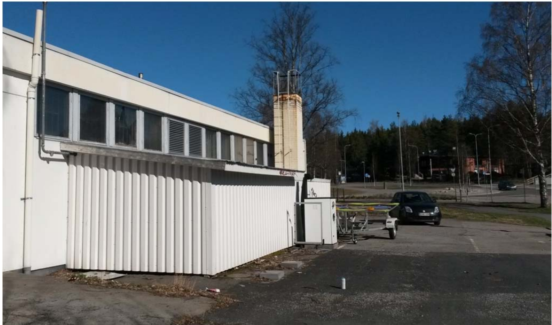
Kuva 3, Rakennuksen takana sijaitseva mahdollinen säiliö.
