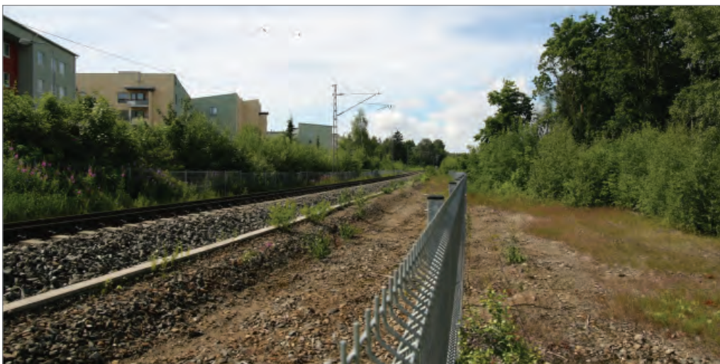
Kuva 9. Näkymä lännen suuntaan radan pohjoispuolelta noin km:lta 194+400.
