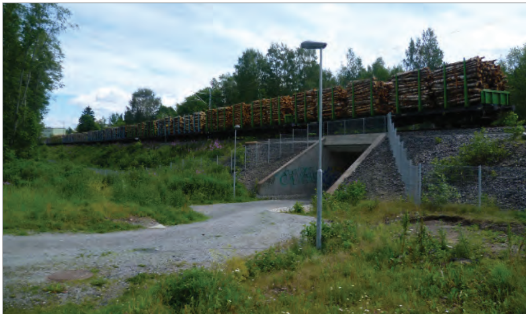
Kuva 11. Näkymä radan pohjoispuolelta Tohlopin alikululle.
