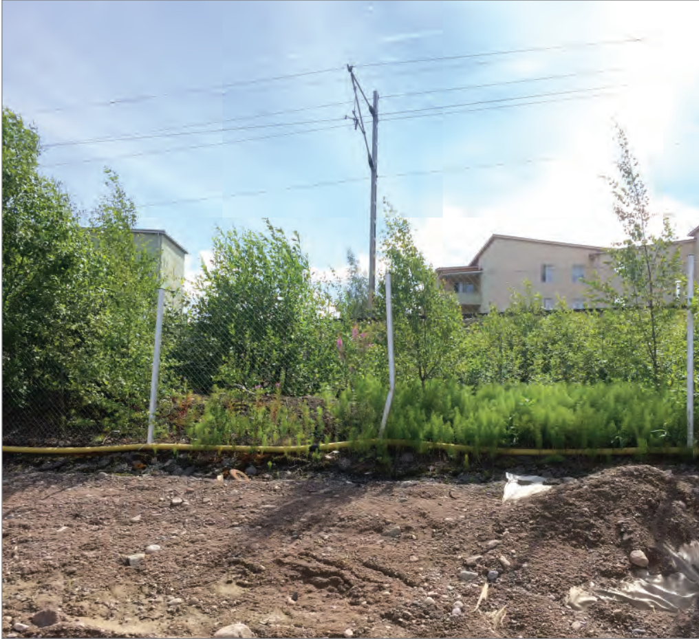
Kuva 14. Nykyiset radan sähköratapylväät sijaitseva radan eteläpuolella.
