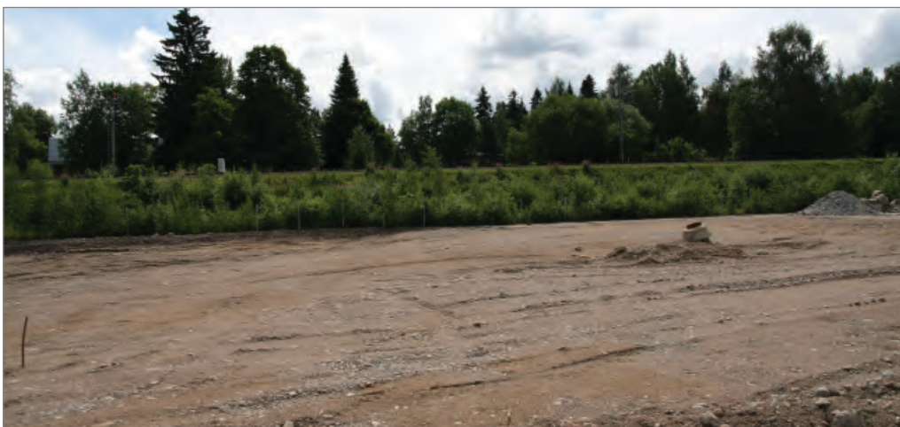
Kuva 10. Näkymä Abloyn tontilta radan suuntaan noin km:lla 194+800. Rata on korkealla penkereellä ja sen pituuskaltevuus on nouseva länteen päin.
