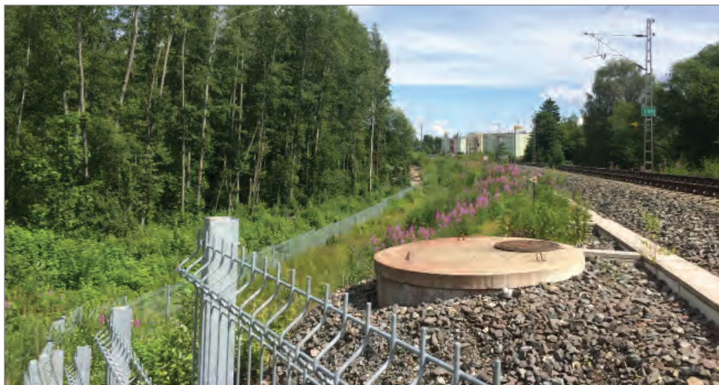
Kuva 24. Näkymä Tohlopin alikulkusillalta itään päin. Kaapelikaivot ja -kourut joudutaan siirtämään lisäraiteen alta pois uuteen sijaintiin.
