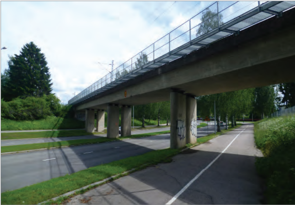
Kuva 16. Näkymä Tesoman alikulkusillan pohjoispuolelta.
