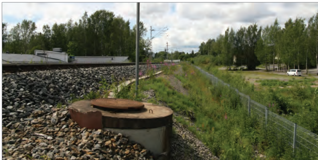
Kuva 25. Näkymä Tesoman alikulkusillalta länteen päin. Kaapelikaivot ja -kourut joudutaan siirtämään lisäraiteen alta pois uuteen sijaintiin.
