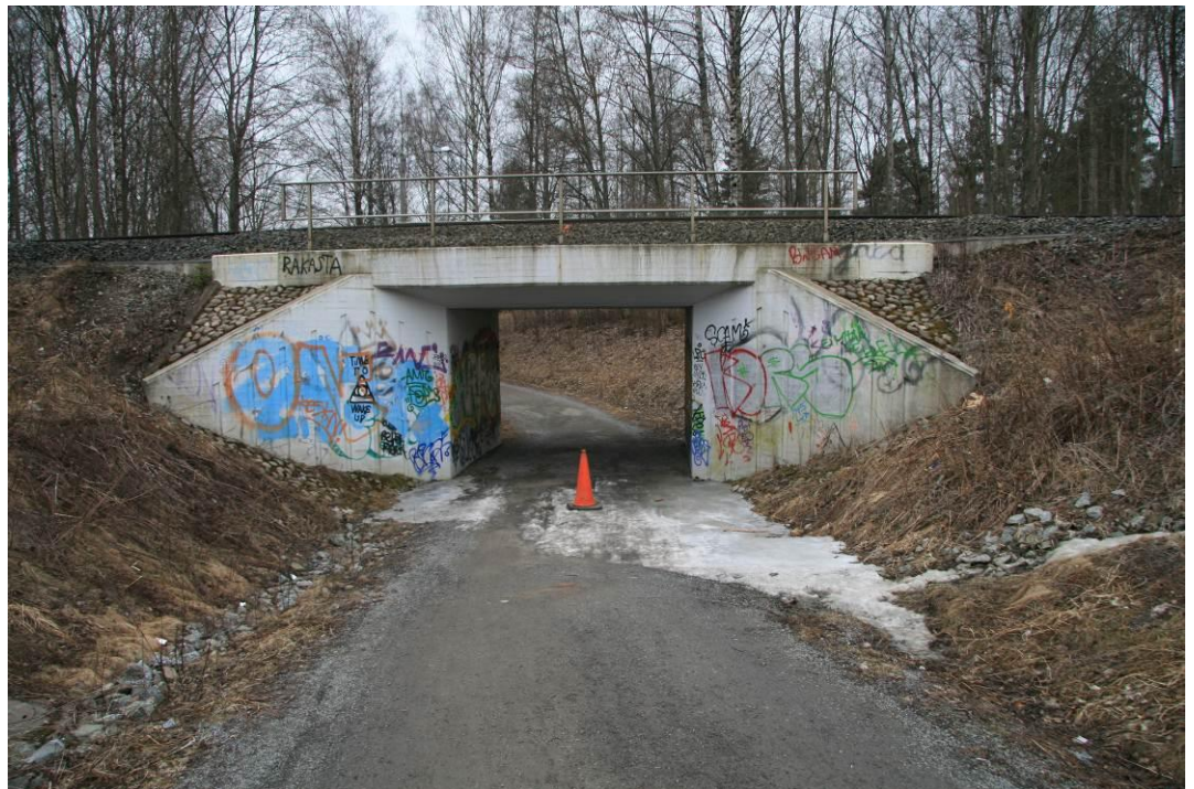
Kuva 5. Suunnittelualueen eteläosassa oleva rautatien alikulkukäytävä.
