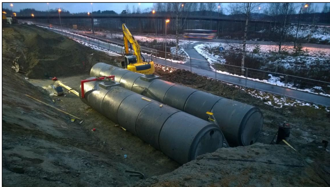
Kuva 11. DN2000 EK-betoniputkista tehty viivytyssäiliö.
