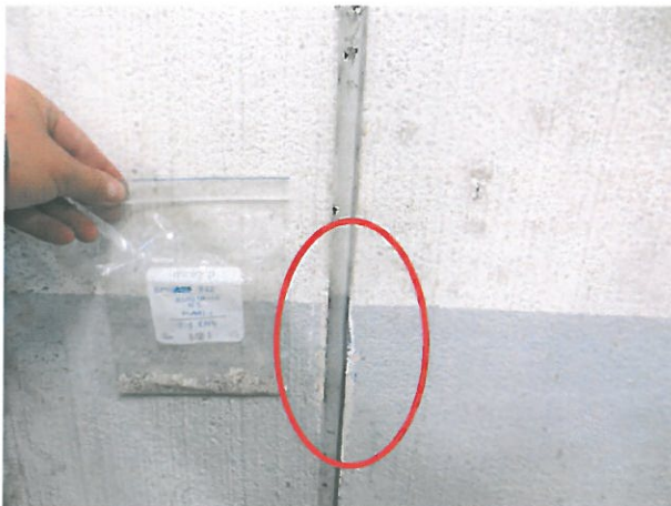
Kuva 3.18 Harmaa seinämaali, korjaamo, RMN 922
