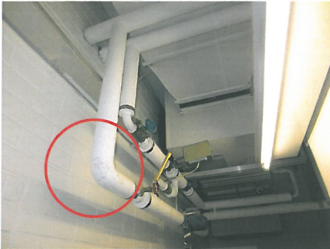
Kuva 3.3 Lämpöputkien eristeet, ASB301
