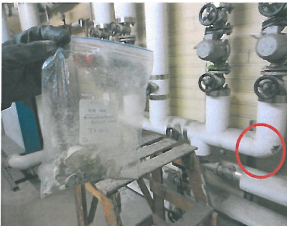
Kuva 3.4 Lämpöputkien eristeet, ASB304
