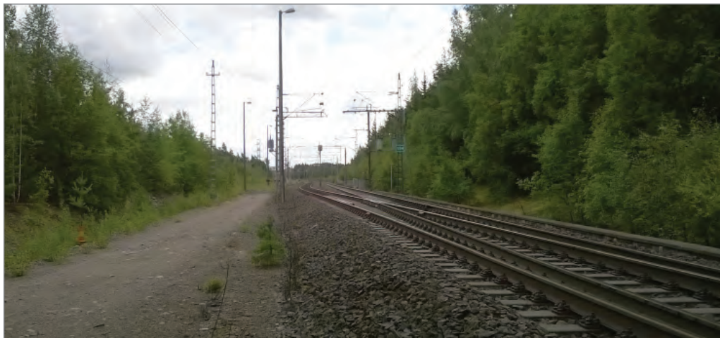
Kuva 34. Näkymä etelän suuntaan Lielahden liikennepaikan Ylöjärven suunnan pohjoispäästä noin km:ltä 194+100.
