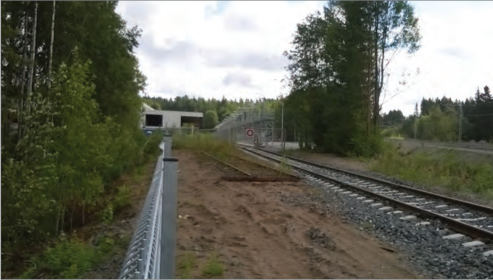
Kuva 51. Näkymä huoltovarmuuskeskuksen portille noin km:n 202+100 kohdalta.
