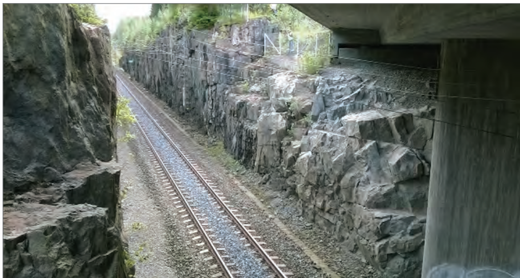
Kuva 43. Näkymä etelän suuntaan Takamaan ylikulkusiltaapaikalta noin km:ltä 205+050.
