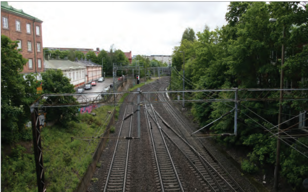
Kuva 20. Näkymä Lapintien ylikulkusillalta etelän suuntaan.
