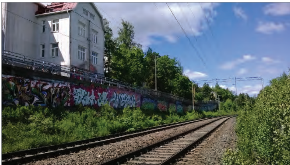
Kuva 29. Näkymä pohjoisen suuntaan noin km:ltä 191+050.
