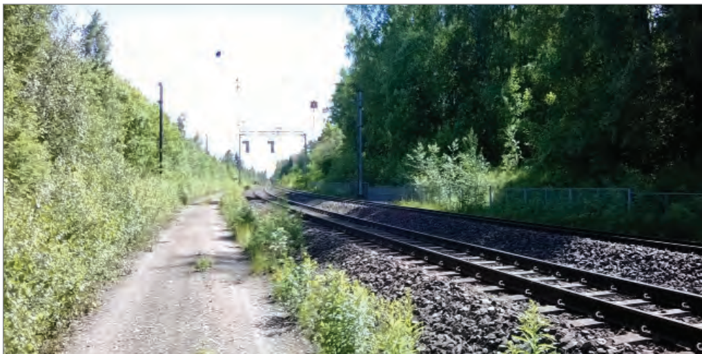
Kuva 30. Näkymä etelän suuntaan noin km:ltä 192+050.
