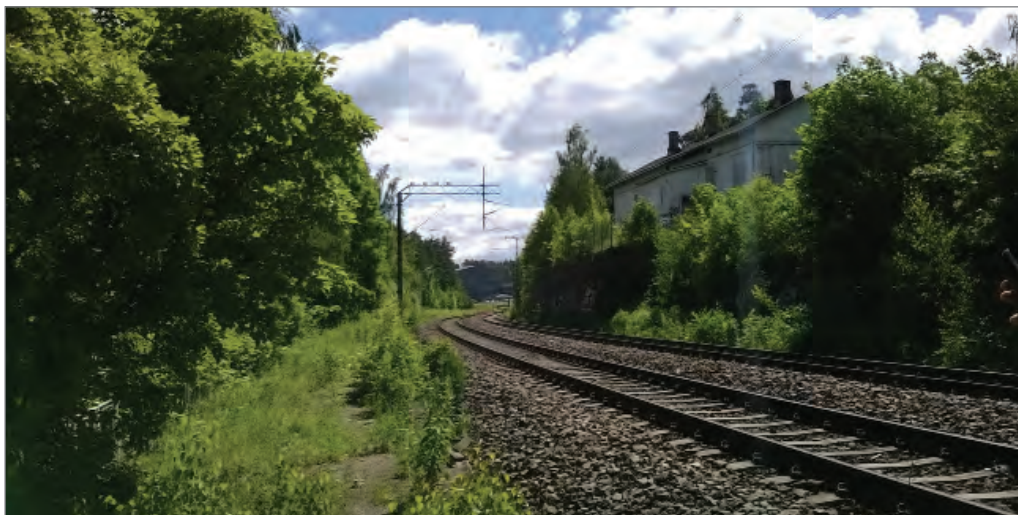
Kuva 28. Näkymä etelän suuntaan noin km:ltä 191+050.
