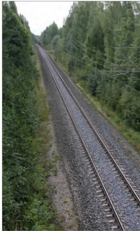
Kuva 38. Näkymä Mäkkylän yksityistien ylikulkusillalta etelän suuntaan, km 198+391.
