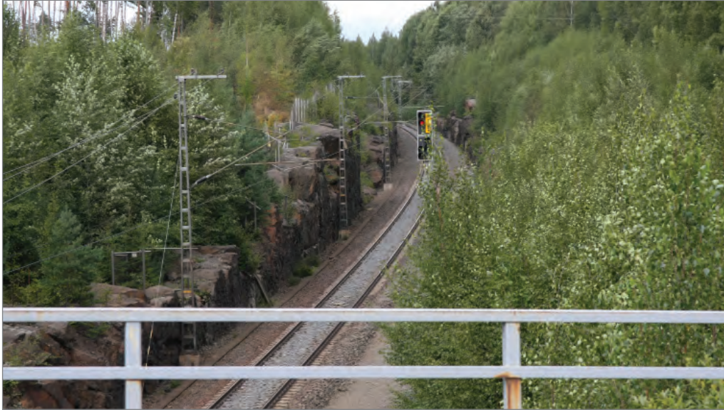
Kuva 36. Näkymä Teivaalan ylikulkusillalta pohjoisen suuntaan, km 196+992.
