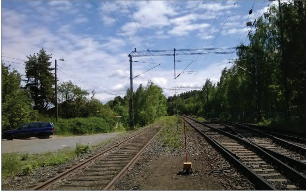
Kuva 31. Näkymä etelän suuntaan noin km:ltä 192+550.
