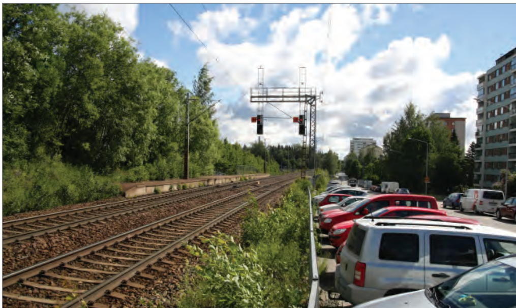
Kuva 26. Näkymä etelän suuntaan noin km:ltä 189+900.
