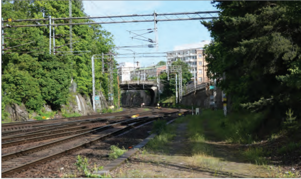
Kuva 19. Näkymä suunnittelualueen rajalta noin km:ltä 188 pohjoisen suuntaan.
