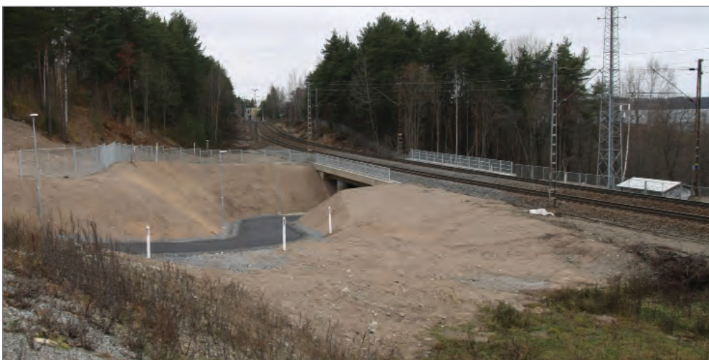
Kuva 27. Näkymä pohjoisen suuntaan, km 190+753 Tipotien alikulku.
