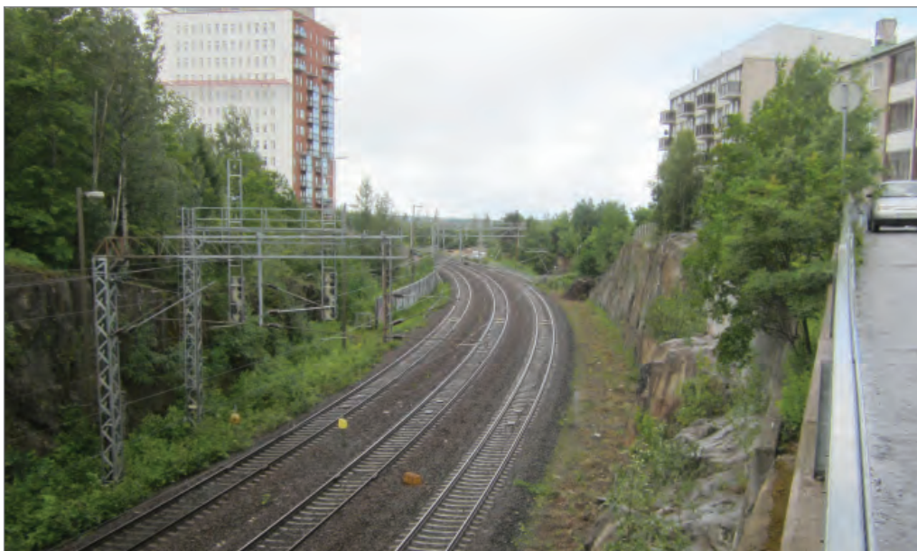
Kuva 21. Näkymä Pajakadulta pohjoisen suuntaan noin km:n 188+200 kohdalta.
