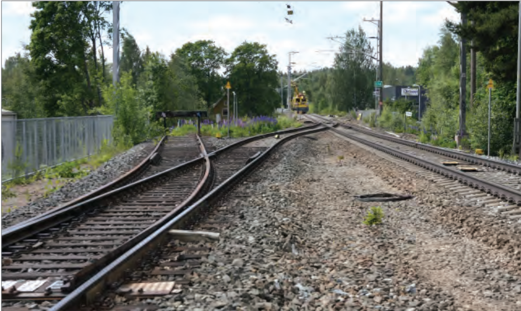
Kuva 45. Näkymä lännen suuntaan Lielahden lp:n Nokian suunnan pohjoispäästä, noin km:ltä 193+900.
