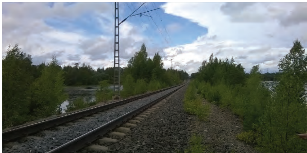
Kuva 40. Keijärven ratapenger etelärannalta kuvattuna noin km:n 199+000 kohdalla.
