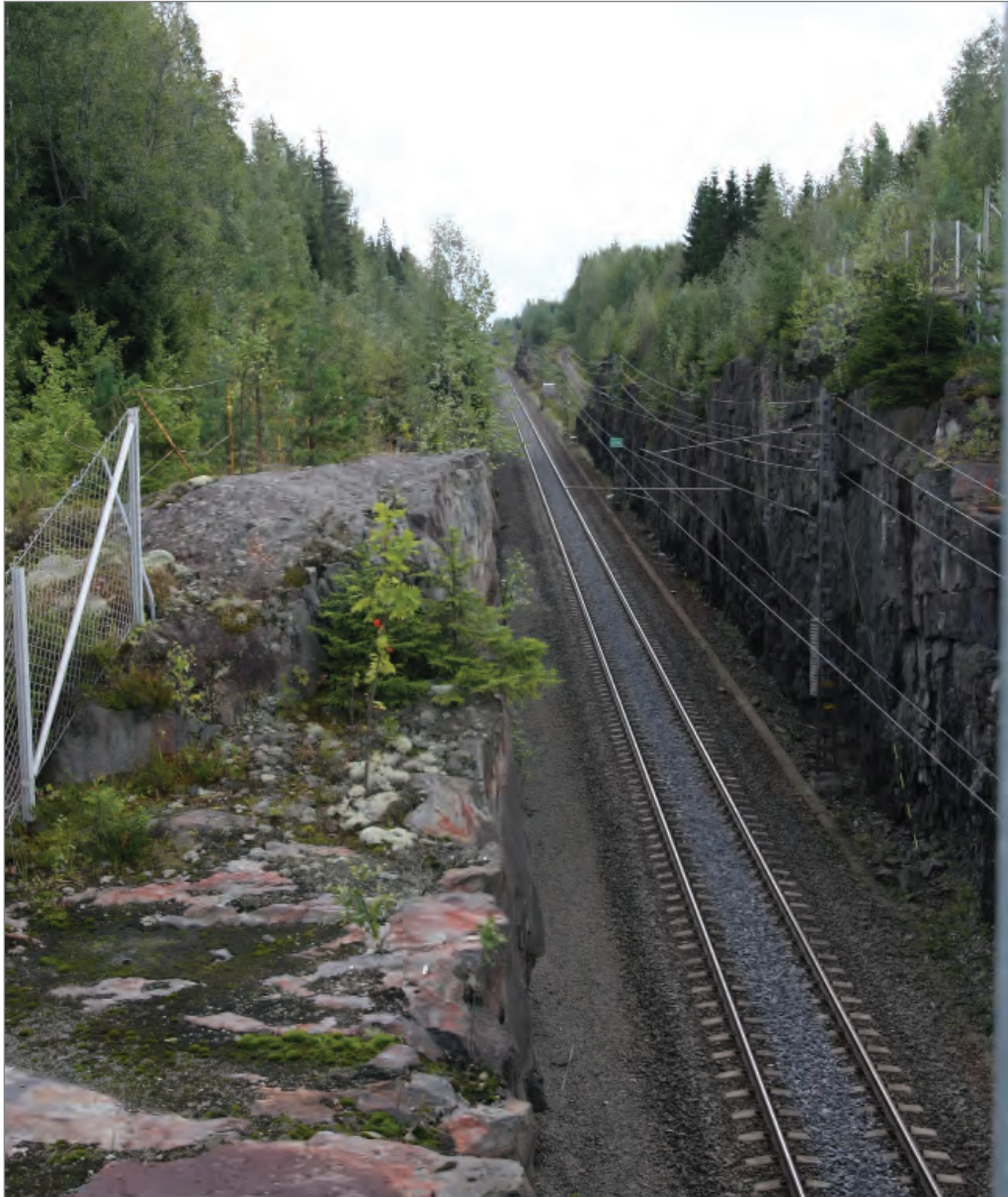
Kuva 14. Perkonmäen Natura-alue (kuvassa radan vasemmalla puolella) kantatien 65 sillalta etelän suuntaan kuvattuna.
