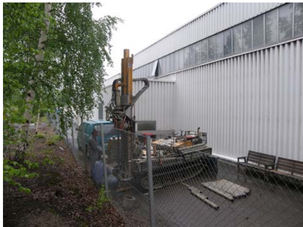
Kuva 7. Havaintoputken HP FCG7 asennus
