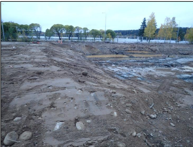
Kuvat 27 ja 28. 30.9.2015 ja 17.9.2015. Kunnostuskaivannon länsireuna sekä itäreuna. Itäreunan läheltä 16-linjan läpi meni vanha putki, jota ei ollut kartoissa. Putkea ei lähdetty rikkomaan, koska ei ollut tietoa kulkeeko siinä edelleen vesi.
