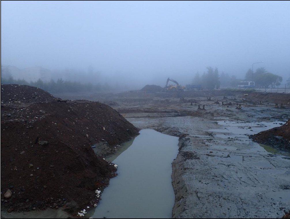
Kuva 14. 31.7.2015. Kaivu jatkui ruutujen A11 ja B11 osalta.
