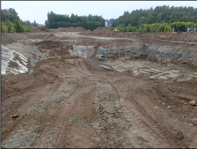
Kuva 26. 21.9.2015 ja 23.9.2015. Kaivua jatkettiin eteenpäin samaan tahtiin kun kaivantoa saatiin täytettyä. Lopulta kaivanto oli lähes kokonaan täytetty.
