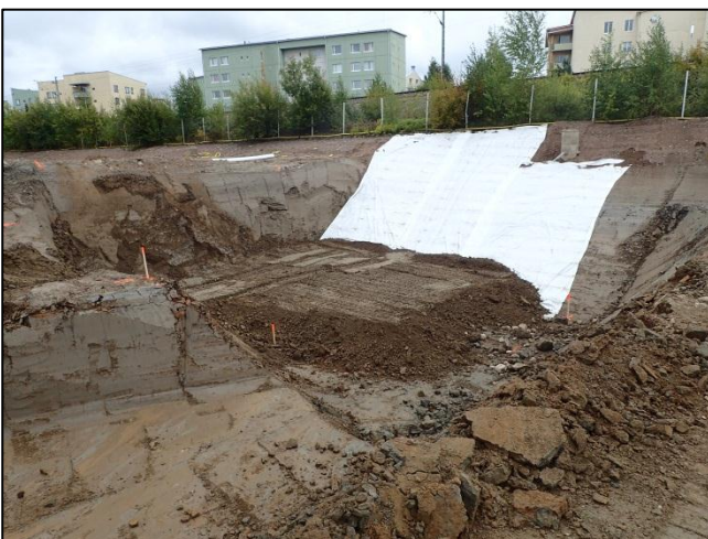
Kuvat 24 ja 25. 4.9.2015 ja 10.9.2015. Liutinaltaan kohdalle junaradan vastaiselle seinämälle laitettiin suodatinkangas, mutta pohjalle ei.
