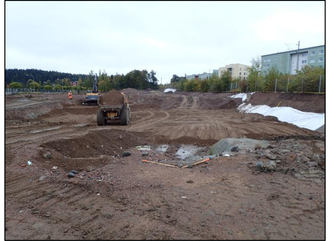
Kuva 26. 21.9.2015 ja 23.9.2015. Kaivua jatkettiin eteenpäin samaan tahtiin kun kaivantoa saatiin täytettyä. Lopulta kaivanto oli lähes kokonaan täytetty.
