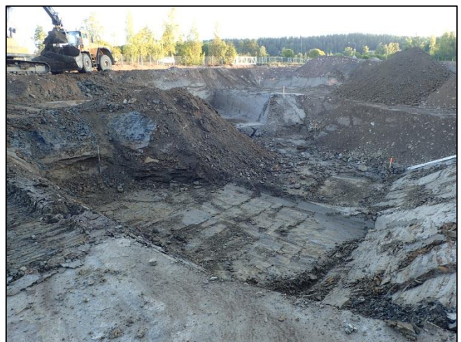
Kuvat 24 ja 25. 4.9.2015 ja 10.9.2015. Liutinaltaan kohdalle junaradan vastaiselle seinämälle laitettiin suodatinkangas, mutta pohjalle ei.
