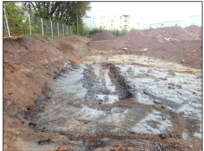
Kuvat 27 ja 28. 30.9.2015 ja 17.9.2015. Kunnostuskaivannon länsireuna sekä itäreuna. Itäreunan läheltä 16-linjan läpi meni vanha putki, jota ei ollut kartoissa. Putkea ei lähdetty rikkomaan, koska ei ollut tietoa kulkeeko siinä edelleen vesi.
