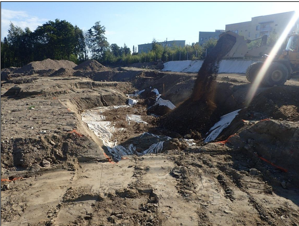
Kuva 19. Alueet, joille jäi haitta-ainepitoisuuksia, erotettiin täyttömaista suodatinkankaalla. Näille alueilla käytettiin myös kynnsarvotäyttömaita täytön pohjalla.
