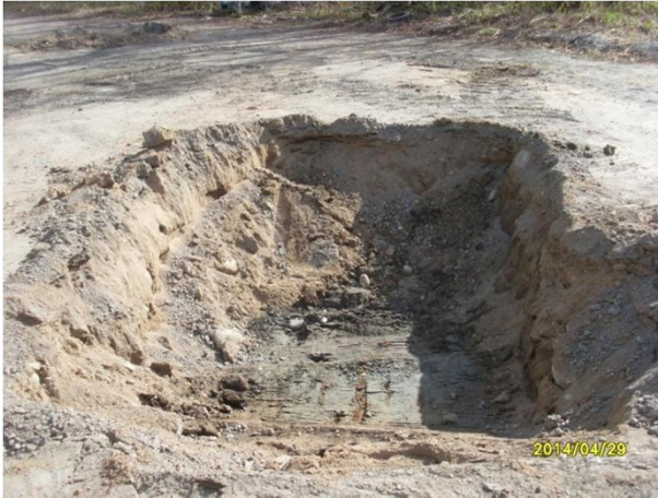
Kuva 9. Jäännöspitoisuusalueet JP11 ja JP12. Kaivamista vielä jatkettiin laboratoriotulosten saavuttua.
