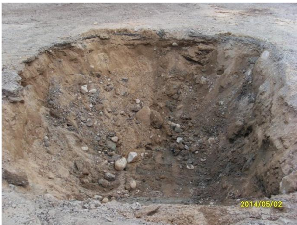
Kuva 15. Kuvassa on jäännöspitoisuusalue JP17. Kaivannon syvyys on n. 1,6 metriä.
