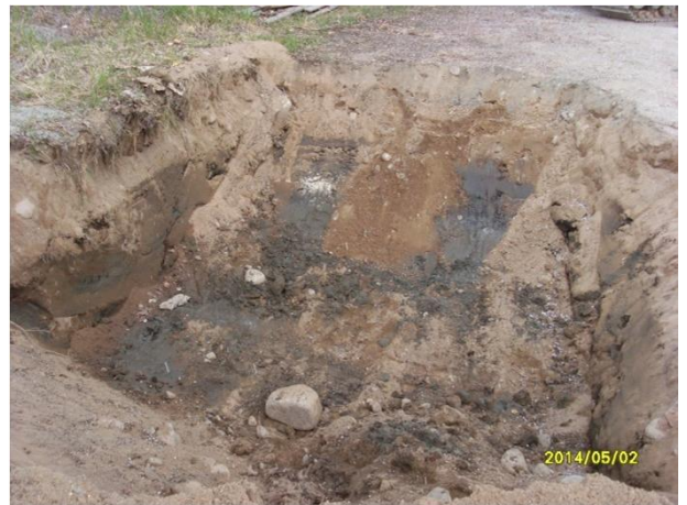
Kuva 14. Kuvassa on jäännöspitoisuusalue JP16. Kaivannon syvyys on n. 1,6 metriä.
