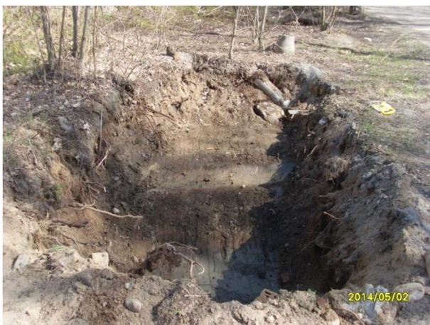
Kuvat 17-18. Kuvissa on jäännöspitoisuusalue JP19. Kaivannon syvyys on n. 1,3 metriä.
