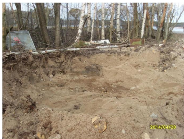
Kuvat 1-2. Kuvissa ovat jäännöspitoisuusalueet JP1 ja JP2. Kaivannon syvyys noin 1 m.
