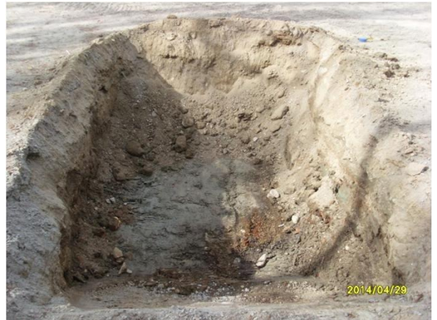
Kuva 10. Jäännöspitoisuusalue JP13. Kaivamista vielä jatkettiin laboratoriotulosten saavuttua.
