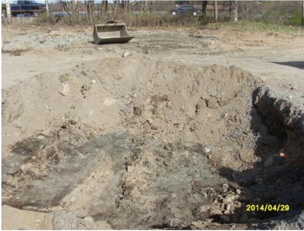
Kuva 7. Kuvassa ovat jäännöspitoisuusalueet JP8 ja JP9. Kaivannon syvyys n. 1,1 metriä.
