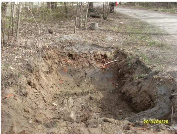
Kuva 11. Jäännöspitoisuusalue JP14. Kaivamista vielä jatkettiin laboratoriotulosten saavuttua.
