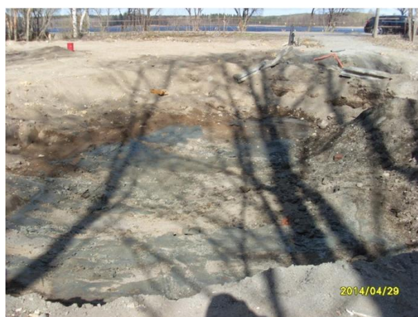
Kuva 6. Kuvassa oikealla itäseinämä JP6, jonka kaivamista vielä jatkettiin laboratoriotulosten saavuttua.
