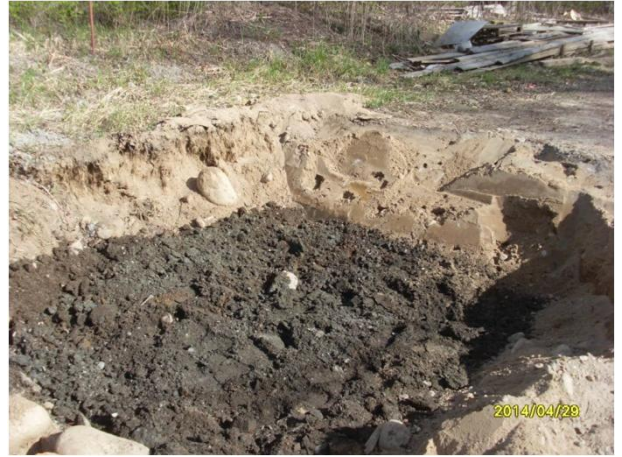
Kuva 8. Kuvassa on jäännöspitoisuusalue JP10, jonka kaivamista vielä jatkettiin laboratoriotulosten saavuttua.
