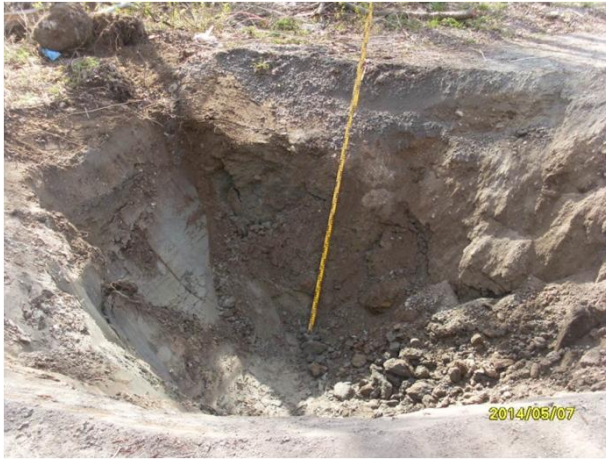
Kuva 19. Kuvassa on jäännöspitoisuusalue JP20. Kaivannon syvyys on n. 2,4 metriä.
