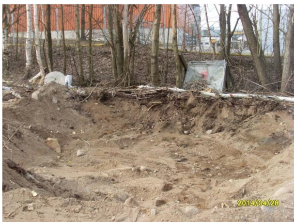
Kuvat 1-2. Kuvissa ovat jäännöspitoisuusalueet JP1 ja JP2. Kaivannon syvyys noin 1 m.
