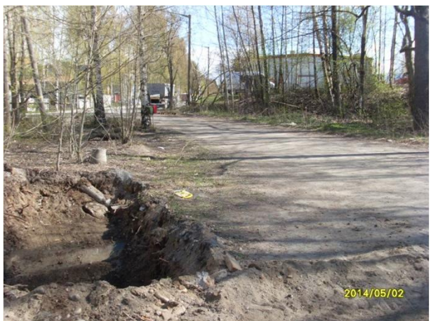
Kuvat 17-18. Kuvissa on jäännöspitoisuusalue JP19. Kaivannon syvyys on n. 1,3 metriä.
