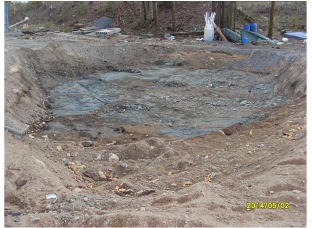
Kuvat 20-21. Kuvia kunnostetuista kaivannoista.
