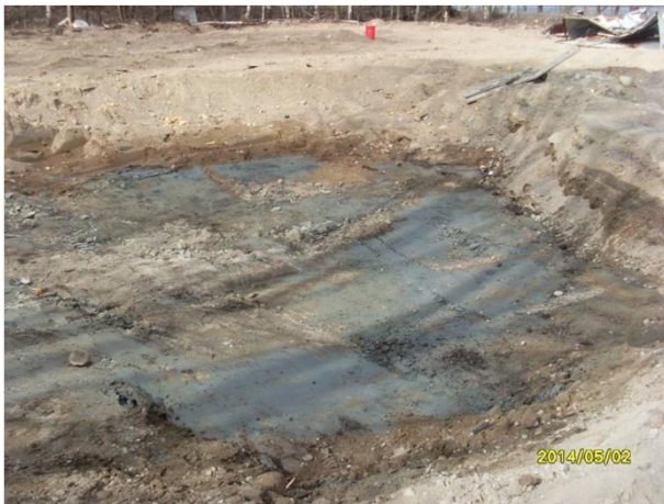
Kuva 13. Kunnostettu, isoin kaivanto. Kuvassa näkyvät jäännöspitoisuusalueet JP3, JP4, JP7 ja JP15. Kaivannon syvyys n. 1-1,5 metriä.
