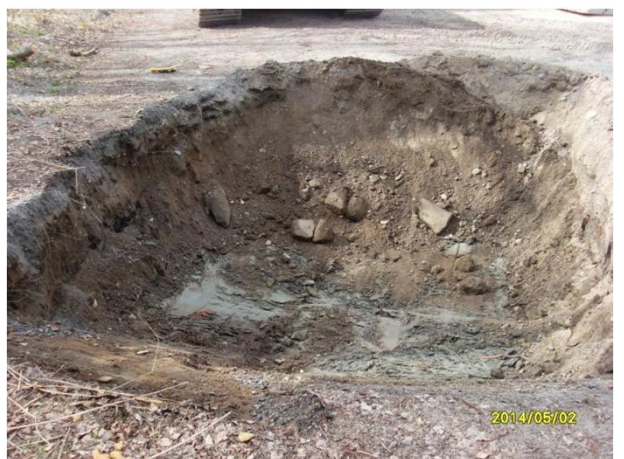
Kuva 16. Kuvassa on jäännöspitoisuusalue JP18. Kaivamista vielä jatkettiin laboratoriotulosten saavuttua.
