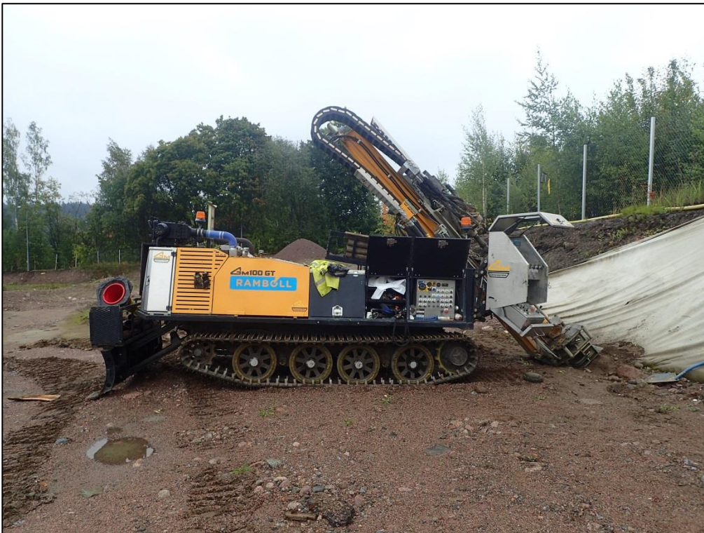
Kuva 2. Junaradan suuntaan tehtiin 5 vinokairausta.
