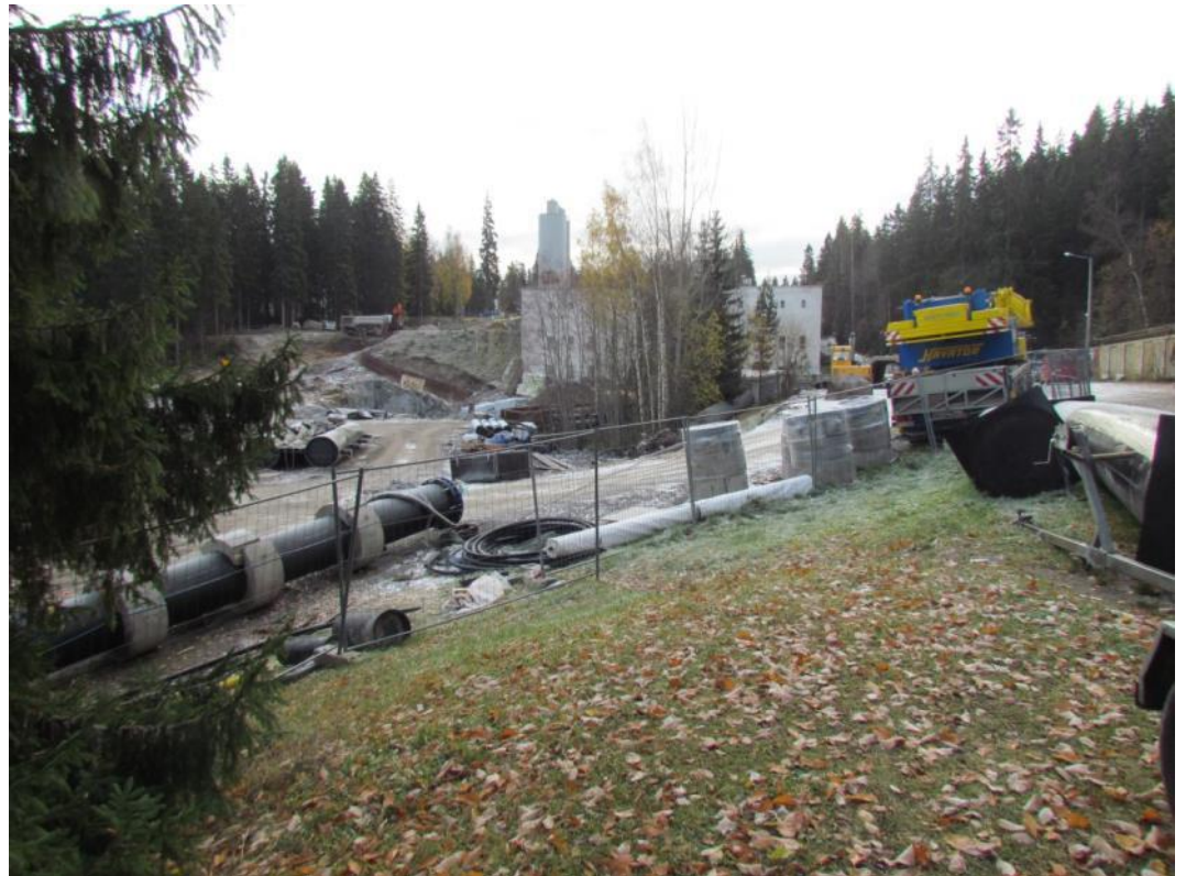
Kuva 4. Kuvan keskellä näkyvä pengeri on todennäköisesti suurelta osin täyttömaata. Kaupinojan sahan rakenteita saattaa olla säilynyt täyttömaan alapuolisissa kerroksissa.
