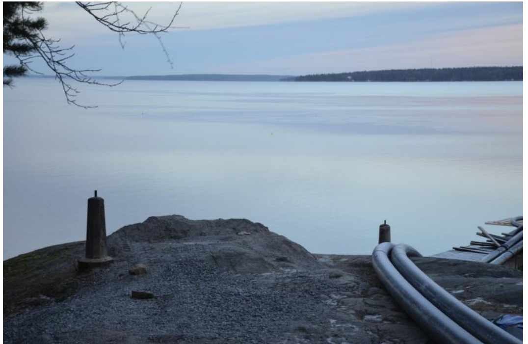
Kuva 6. Kaupinojanlahden molemmilla rannoilla on betonipylväitä, joiden päällä on kiinnittämiseen käytetty tappi. Rakenteet saattavat liittyä sahalle suuntautuneeseen uittotoimintaan tai valmiiden tuotteiden kuljetukseen käytettyjen lotjien kiinnitykseen.
