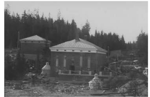
Kuva: Tampereen museoiden kuva-arkisto. Kuva on otettu rakennusvaiheessa 1920-luvulla
