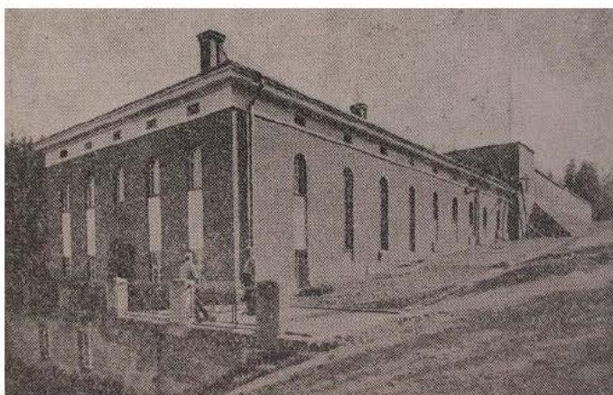
Pumppuasema ennen muutoksia 1940-luvulla
