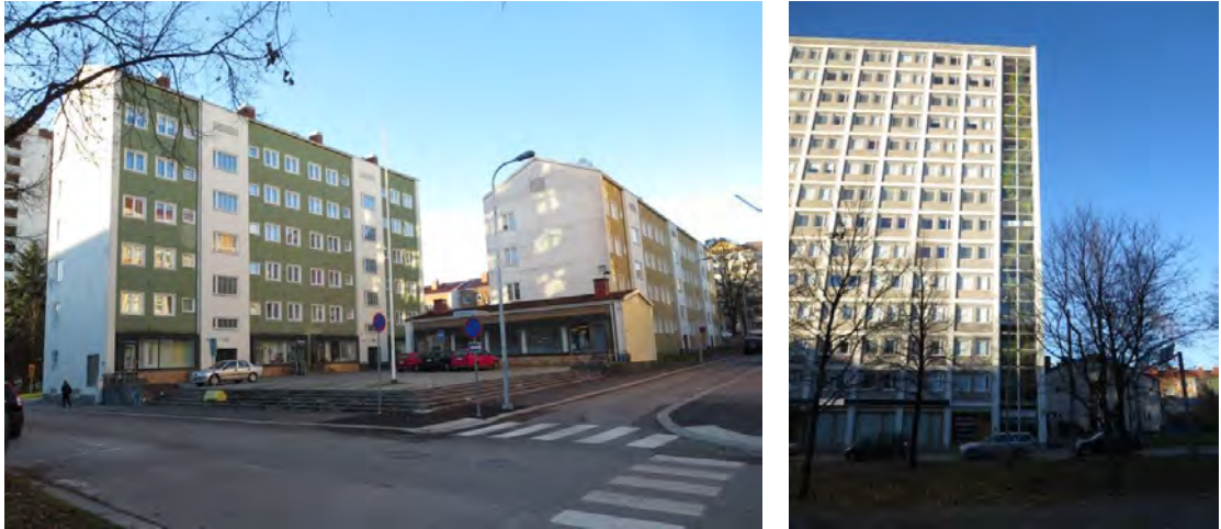
Kuvat 33 ja 34. Amurinlinnan rakennuksia Hämeenpuistosta kuvattuna. Oikealla on Impilinnaksi kutsuttu "pilvenpiirtäjä". Kuvat Aihio Arkkitehdit Oy / KNä.
