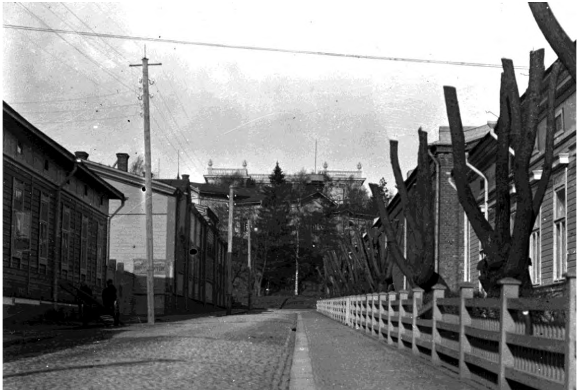
Kuva 55. Kadunpäätäkymä. Milavidat Näsilinnankadun näkymän päätteessä. Kuva Vapriikin kuva-arkisto.
