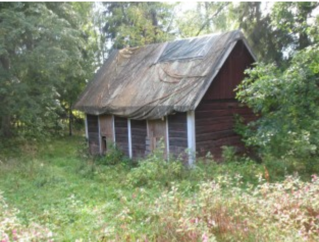
Kuva 4. Varastona oleva ulkorakennus.
