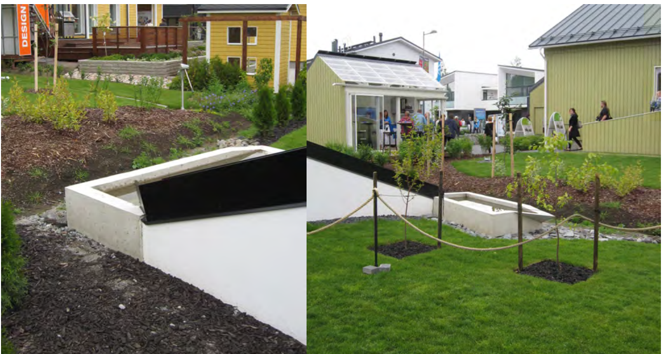
Kuva 7. Kiinteistön sadevesien keräysjärjestelmä Vuoreksessa (kuva Leena Sänkiaho).
