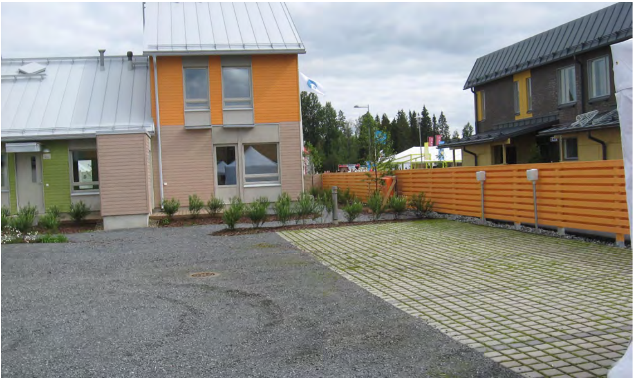
Kuva 4. Lämpäisevää pinnoitetta ja nurmikiveystä Vuoreksessa (kuva Leena Sänkiaho).
