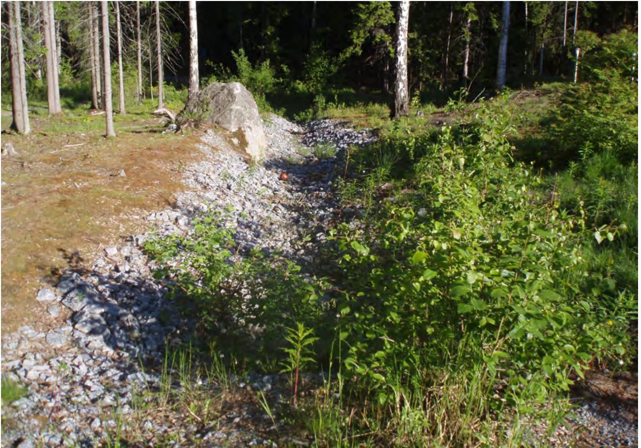
Kuva 6. Imeytysrakenne (kuva Jouni Saranpää).
