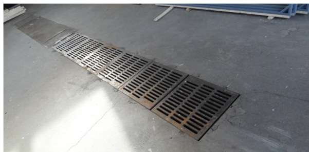
Kuva 12 Hallirakennuksen toinen öljynerotuskaivo
