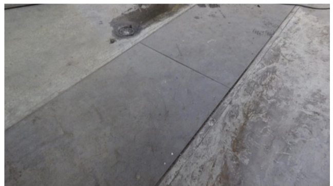
Kuva 16 Kellarikerroksen automaalaamon öljymonttu
