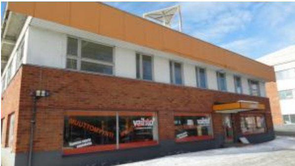
Kuva 10 Lännen puoleinen, vanhempi rakennus
