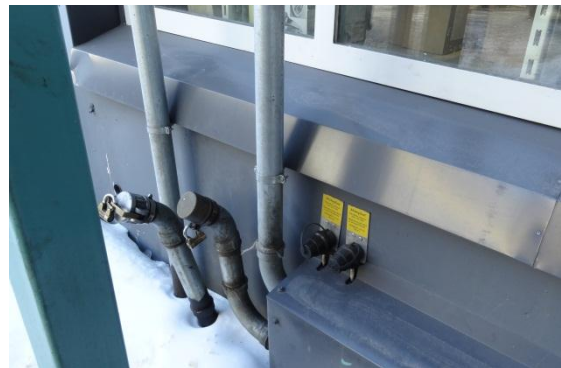
Kuva 3 Sammonkatu 56 öljysäiliön täyttöputki
