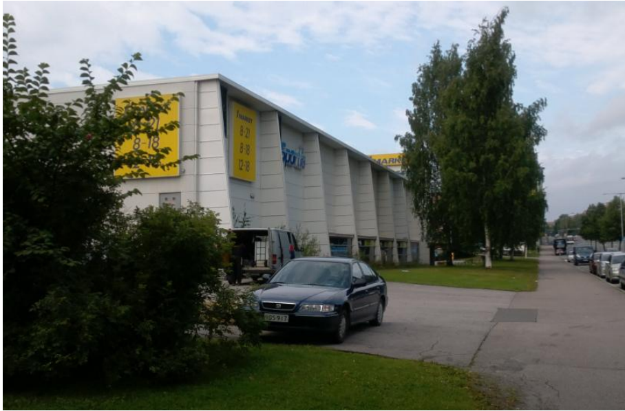
V. 1997 rakennettu liikerakennus, Sammonkatu 60. 8/2013
