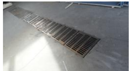
Kuva 9 Sammonkatu 66A huoltohallin kaivot
