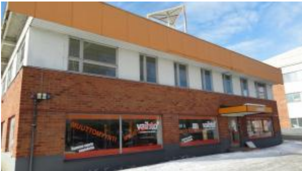
Kuva 10 Lännen puoleinen, vanhempi rakennus
