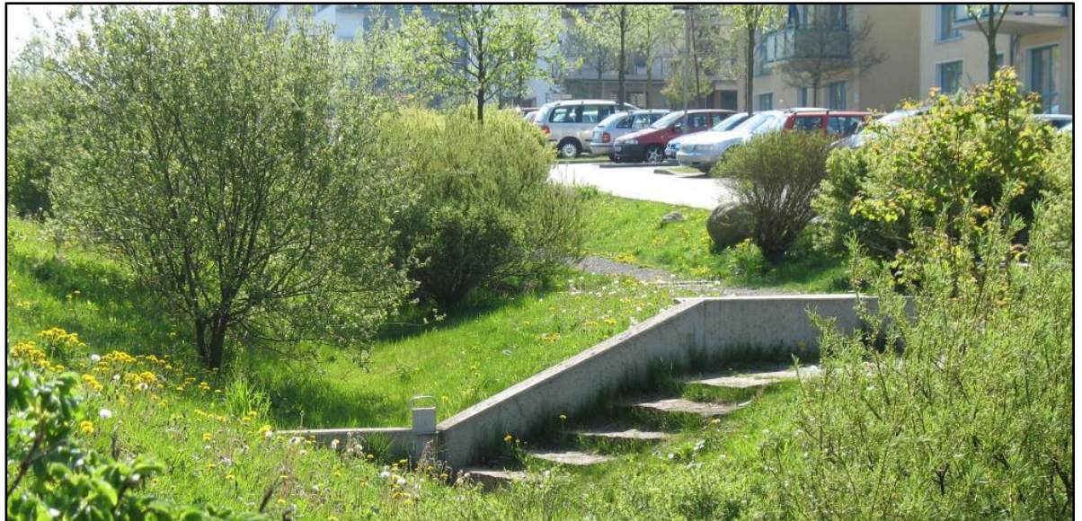
Kuva 7. Viivytysojanteet katu- ja pysäköintialueen päässä. Painanteet rajattu pienellä betonipadolla. Syvyys tulee olla sellainen, että hulevesiviemärien purku painanteeseen on mahdollista. Kuva Hannoverista. 7
