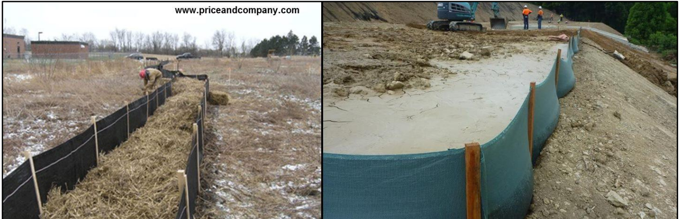
Kuva 13. Esimerkkejä yksinkertaisesti toteutettavista sedimenttiseinistä, joilla pysäytetään hallitsematon pintavalunta ja ehkäistään sedimenttikuormitusta. 8
