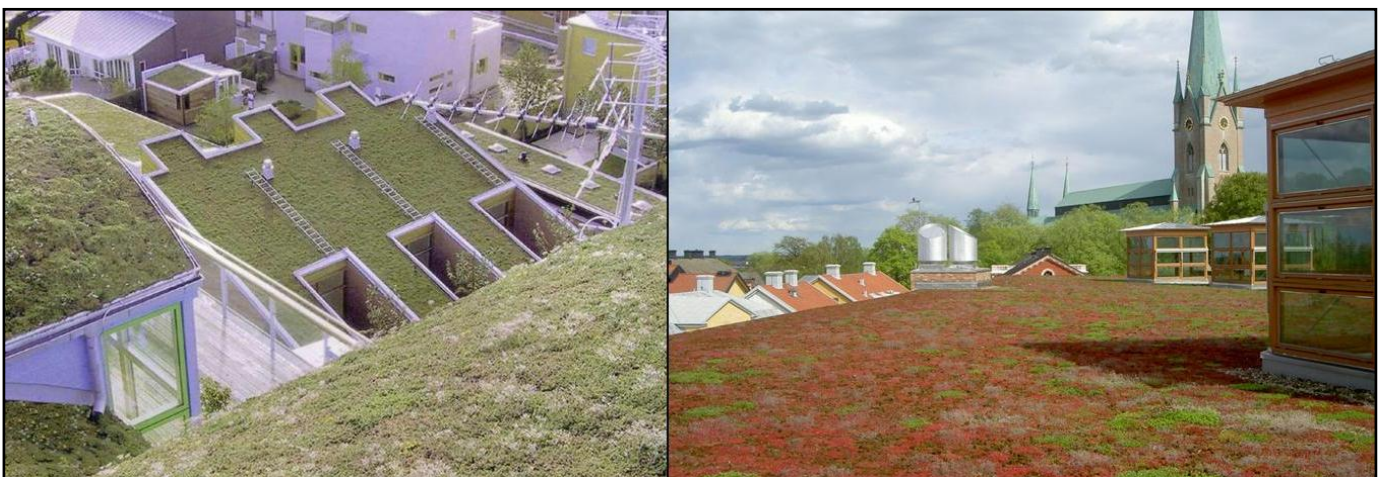
Kuva 3. Sammal-maksaruohokerroksella toteutettuja viherkattoja Ruotsissa. Viherkatto parantaa näkymiä ja voi toimia myös viihtyisänä oleskelualueena. Vasemmalla Malmö, Västra Hamnen; oikealla Linköpingin kirjasto. 5
