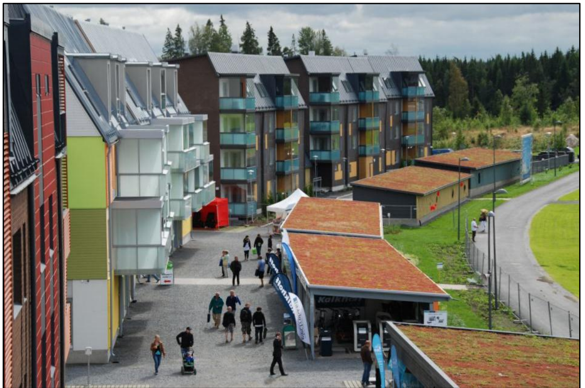
Kuva 6. Viherkaton käyttöä autokatoissa Vuoreksen Virolaisen alueella. 7
