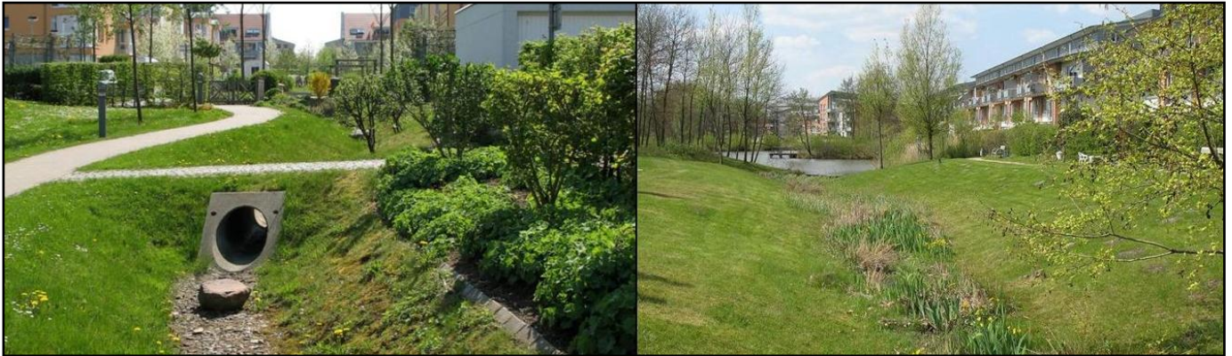
Kuva 10. Hulevesien johtamista avo-ojassa ja viherpainanteessa. Kuvat Saksasta, Hannoverista. 7
