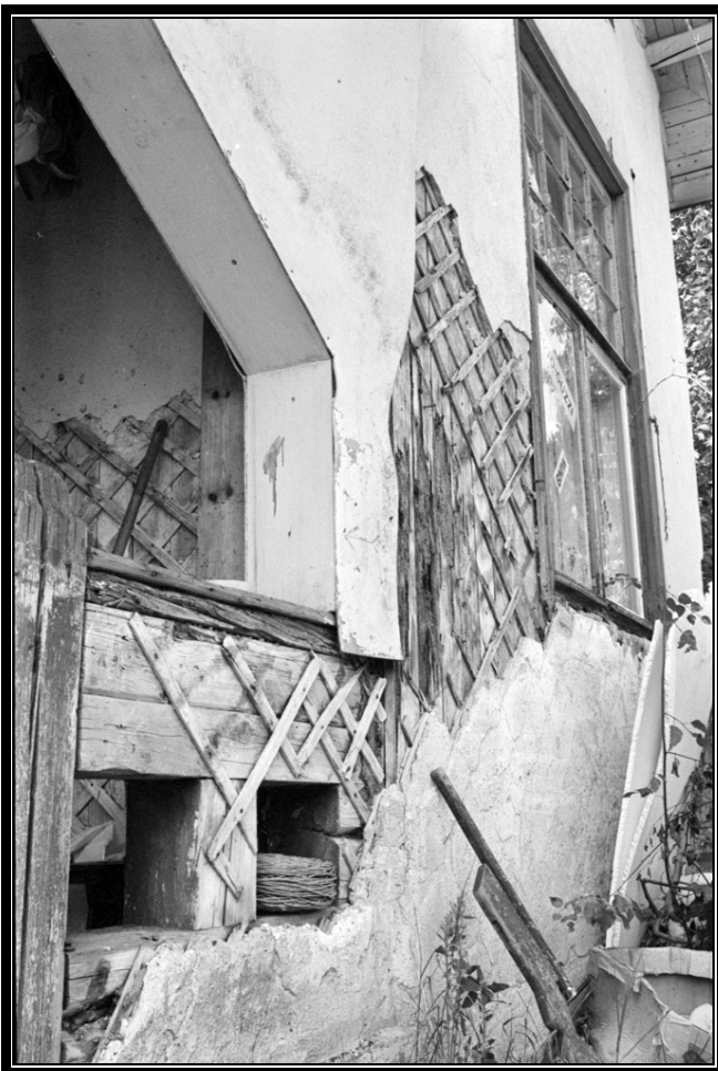
Kuva 3.30. Kartanon päärakennuksen rapistunut seinä elokuussa 1973. Kuvasta näkyy, kuinka rappausta varten seinään on kiinnitetty vinorimoitus. Kuvalähde: Raimo Nieminen, Vapriikin kuva-arkisto.
