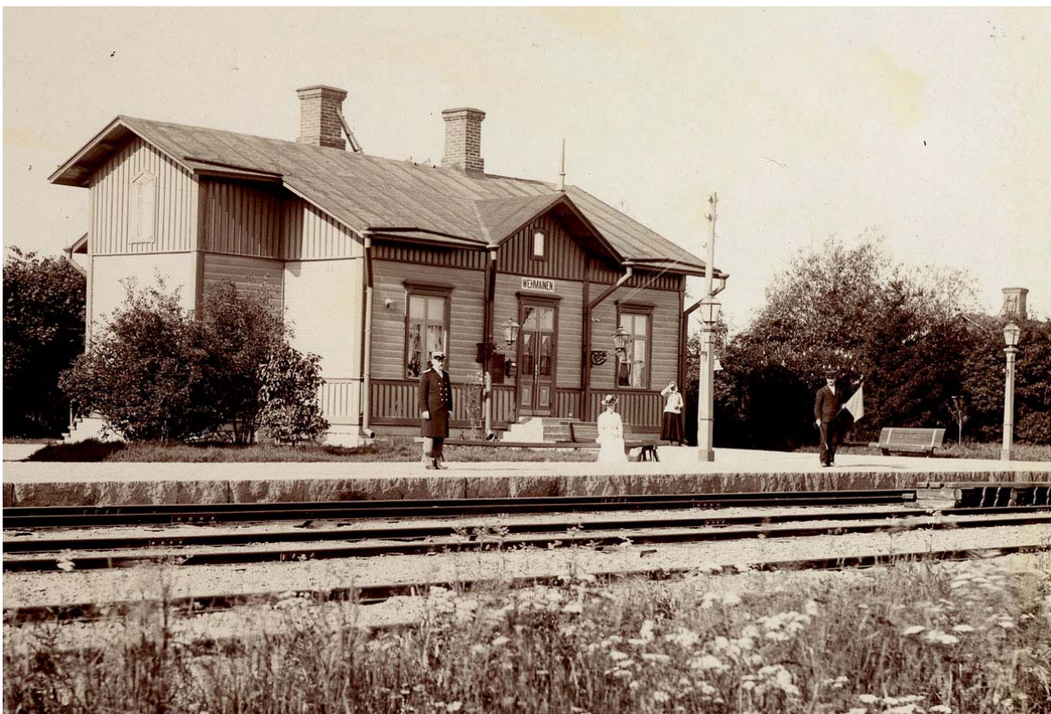
Kuva 2.12. Vehmaisten asemarakennuksen vakituinen rautatiekäyttö päättyi 1970-luvulla. Henkilöliikenne asemalla loppui vuonna 1988 ja tavaraliikenne 1990-luvulla. Huonokuntoinen asemarakennus purettiin vuonna 2000. Kuvälähde: HMSA.
