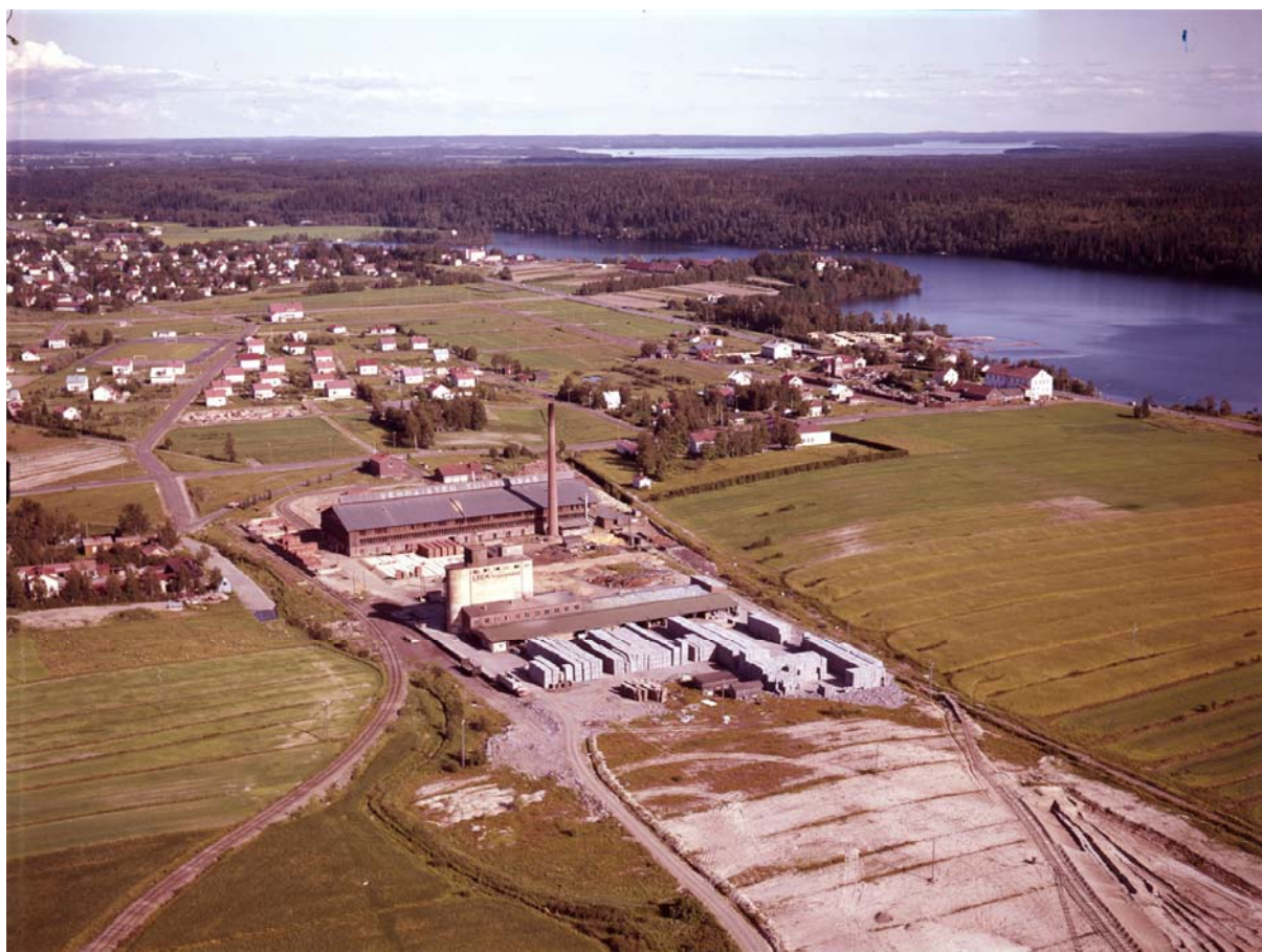
Kuva 2.17. Kaukajärven tiilitehdas 1965. Tiilitehtaan 50-metrinen, 1947 valmistunut piippu erottui kauas ympäristöönsä. Savupiippu purettiin 1972. Kuvälähde: Työväenmuseo Werstas.
