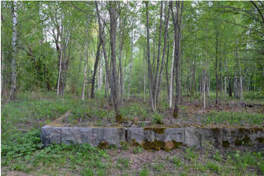
Kuva 27. Navetan hakatuista kivipaasista tehdyn eteläosan perustuksen lounaiskulmaa. (Kuva: Tampere, Kaukaniemen asemakaava-alueen arkeologinen tarkkuusinventointi 2013: 11)
