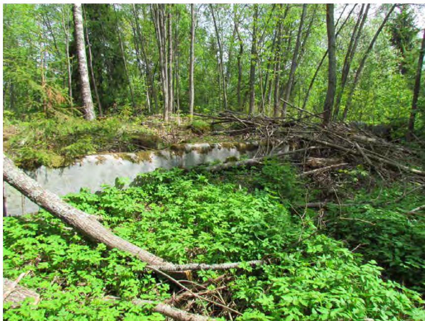
Kuva 45. Päärakennuksen laajennusosan huolellisesti muotoiltua kiviperustusta. (Kuva: Tampere, Kaukaniemen asemakaava-alueen arkeologinen tarkkuusinventointi 2013: 28)
