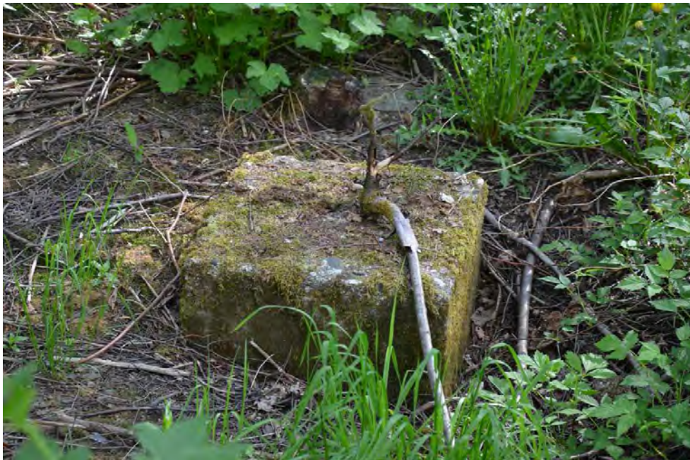
Kuva 14. Osa vajarakennuksesta oli perustettu betonipilareiden päälle. (Kuva: Tampere, Kaukaniemen asemakaava-alueen arkeologinen tarkkuusinventointi 2013:3)
