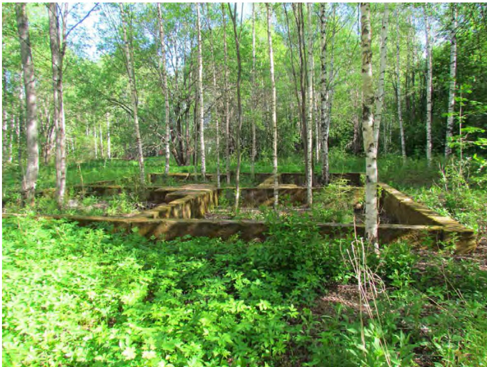
Kuva 12. Pehtorin asunnon perustuksia rakenteen itäpäässä. (Kuva: Tampere, Kaukaniemen asemakaava-alueen arkeologinen tarkkuusinventointi 2013:1)
