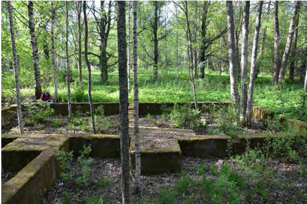
Kuva 13. Pehtorin asunnon perustuksia rakenteen itäpäässä. (Kuva: Tampere, Kaukaniemen asemakaava-alueen arkeologinen tarkkuusinventointi 2013:2)
