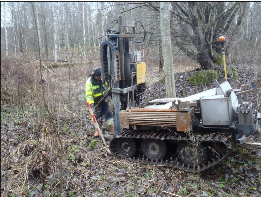
Kuva 4. Osa näytteistä otettiin kairauskalustolla.
