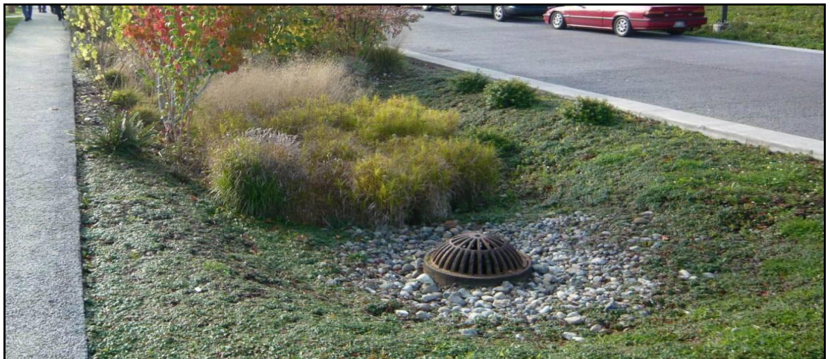
Kuva 15. Esimerkki ylivuotojärjestelmällä varustetusta viherpainanteesta. 4
