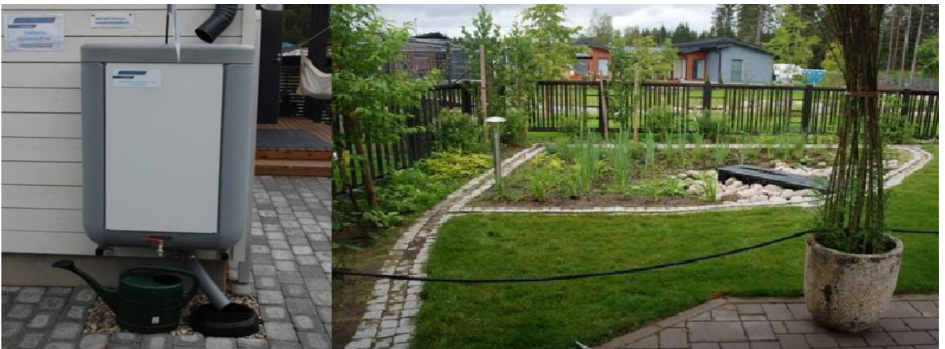
Kuva 12. Vasemalla esimerkki 190 litran kattovesisäiliöstä. Oikealla sadepuutarha, jonne hulevedet johdetaan maanpäällisiä kouruja pitkin. 4
