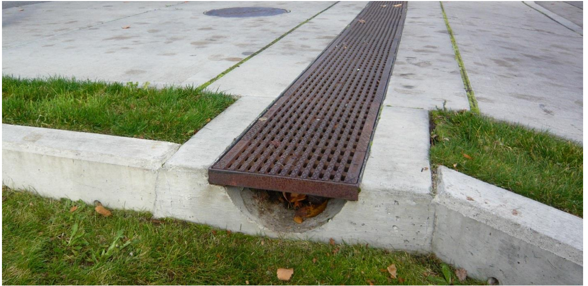
Kuva 14. Viivytyispainanteet yhdistetään koururakenteella, joka voidaan suojata kuvan mukaisesti ritiläkansistolla. 4
