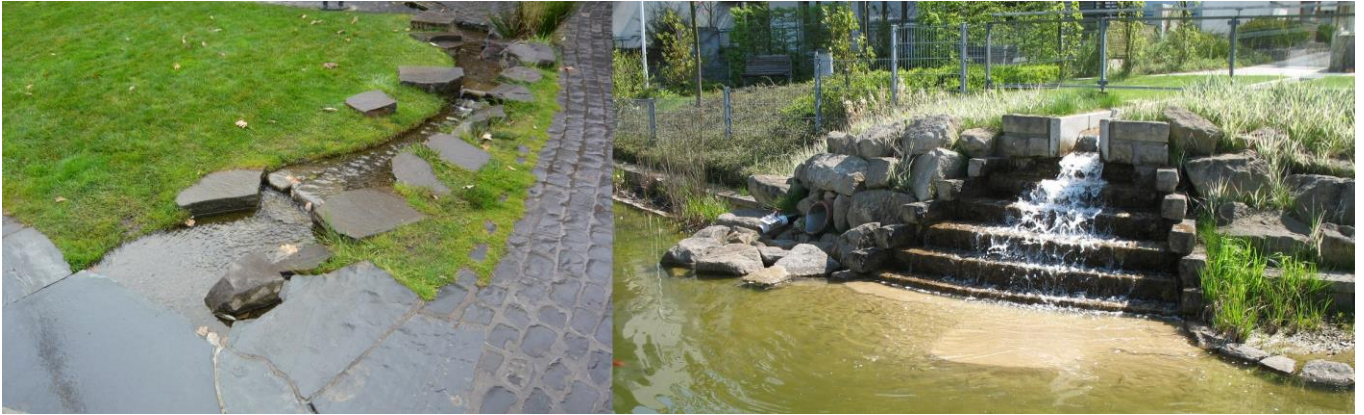
Kuva 13. Hulevesien virtausnopeudet hidastaminen jyrkässä maastonrinteessä onnistuu esimerkiksi porrastetun johtamisjärjestelmän avulla. Vasen kuva: Portland, Oregon. Oikea kuva: Hannover, Saksa. 4
