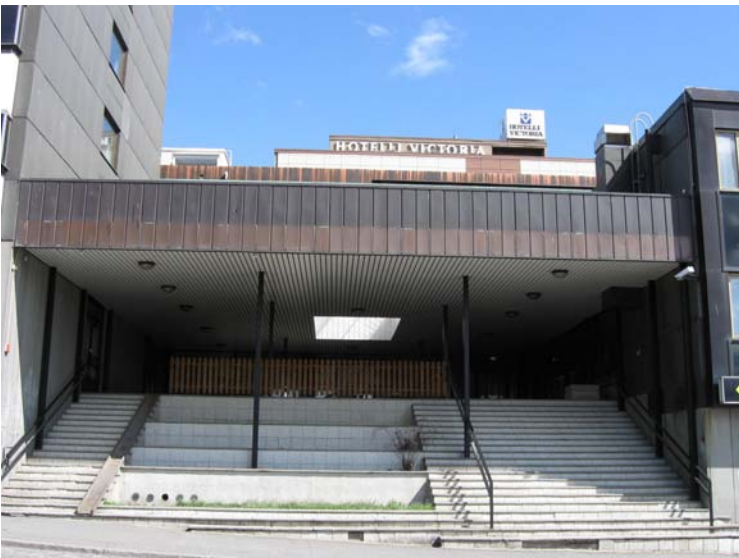
Rasti lännestä: Rastin portaikko (Pekka Ilveskoski 1969) ja sisääntulokatos (1989) Murtokadun puolella
