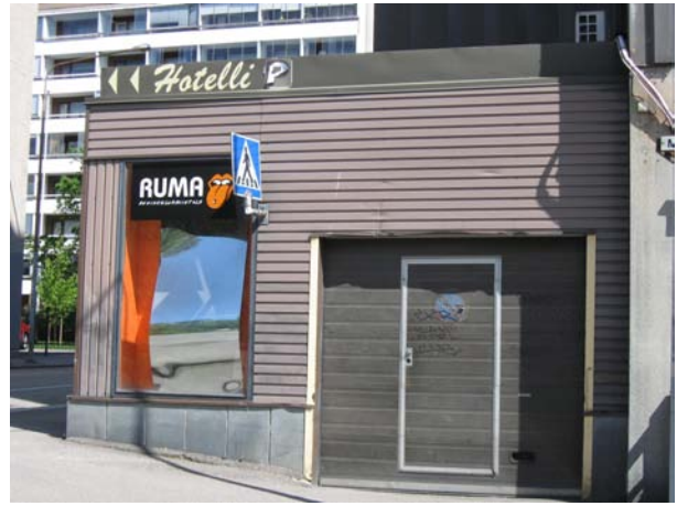
Rasti lännestä: Katettu lisäosa, entinen ajoluiska (1988) Murtokadun puolella
