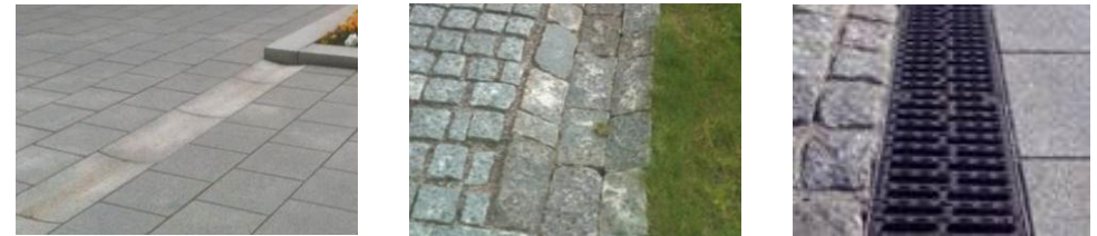
Esimerkkejä pintavesikouruista: kourulaatta, nupukivikouru, linjakuivatuskouru (Kuvat Ramboll ja ACO Nordic Oy)
