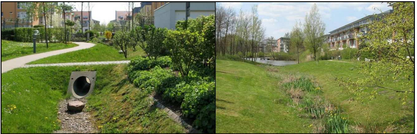
Kuva 15. Hulevesien johtamista avo-ojassa ja viherpainanteessa yleisellä puistoalueella. 5
