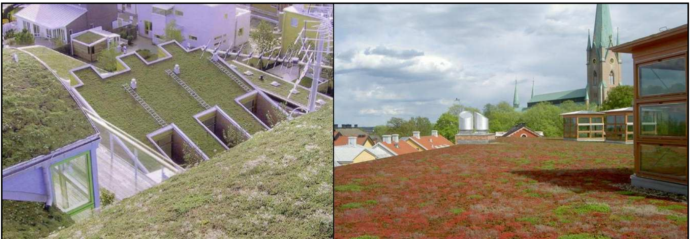
Kuva 9. Sammal-maksaruohokerroksella toteutettuja viherkattoja Ruotsissa. Viherkatto parantaa näkymiä ja voi toimia myös viihtyisänä oleskelualueena. Vasemmalla Malmö, Västra Hamnen; oikealla Linköpingin kirjasto. 9
