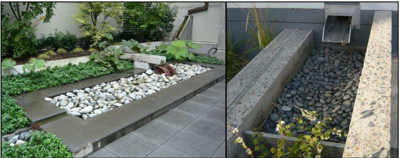
Kuva 10. Kattovedet johdetaan kivipesiin ja näistä istutusalueille. Järjestelmä on osa piha-alueen laadukasta viherrakentamista. 5
