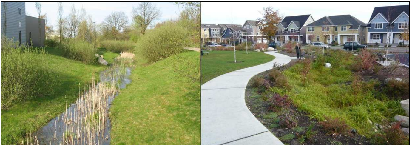
Kuva 16. Hulevesien keskitetty viivytyispainanne on vasemmassa kuvassa sijoitettu tonttien reunaan ja oikealla pienelle puistoalueelle. 5
