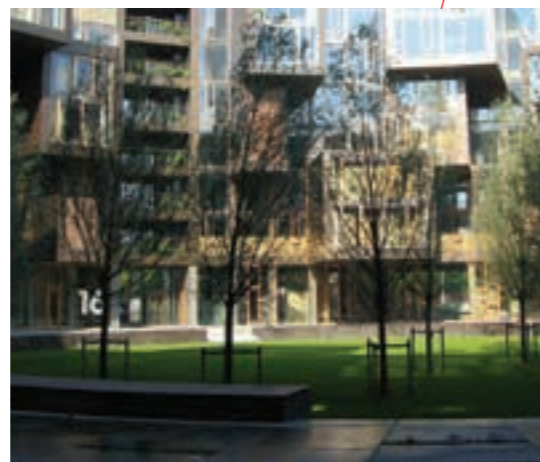
Tietgen kollegiet, Kööpenhamina. Kuva: Tuomas Seppänen / B&M
