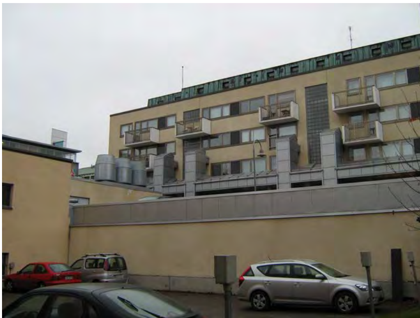
Kuva 3.4. Valokuva Vapaakirkon pihalta kohti Kuninkaankatu 22 rakennusta. Vuonna 1989 sisäpihan puolelle rakennetut ilmastointikanavat ovat mittasuhteiltaan suurikokoisia.
