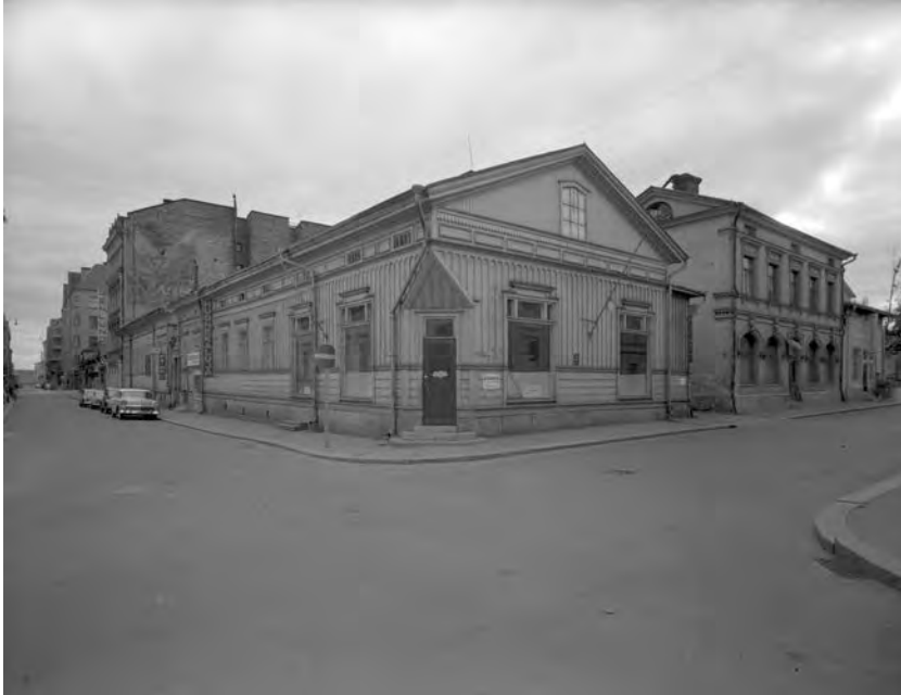
Kuva 2.7. Kuninkaankatu 22 / Puutarhakatu 15 vuonna 1959.
