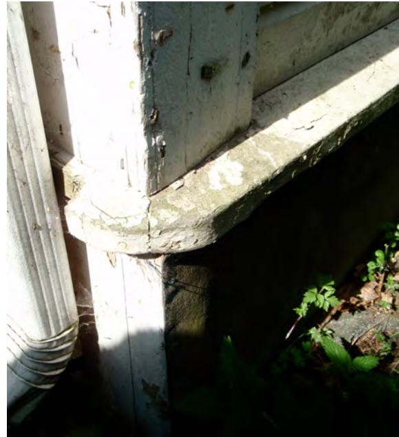
Sammaloitunut porrasrakennelma. Oikealla detaili pohjoisjulkisivun painuneesta sokkelista. Sokkeli on pinnoitettu levyrakenteella.
