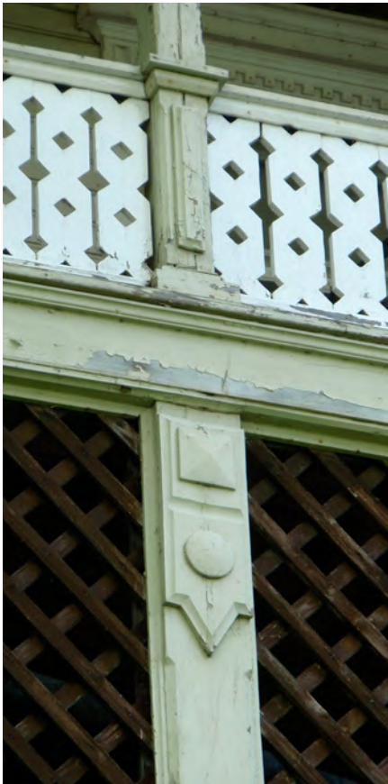
Detalji terrassin pilarista ja kaiteesta. Julkisivut on maalattu lateksilla, maali irtoaa yhtenäisinä levyinä. Oikealla purettun terassiportaan paikka ja ovi sokkeliosaan.
