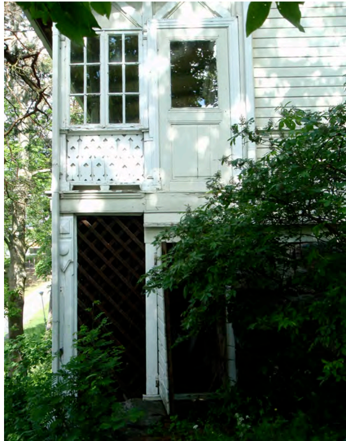
Detalji terrassin pilarista ja kaiteesta. Julkisivut on maalattu lateksilla, maali irtoaa yhtenäisinä levyinä. Oikealla purettun terassiportaan paikka ja ovi sokkeliosaan.
