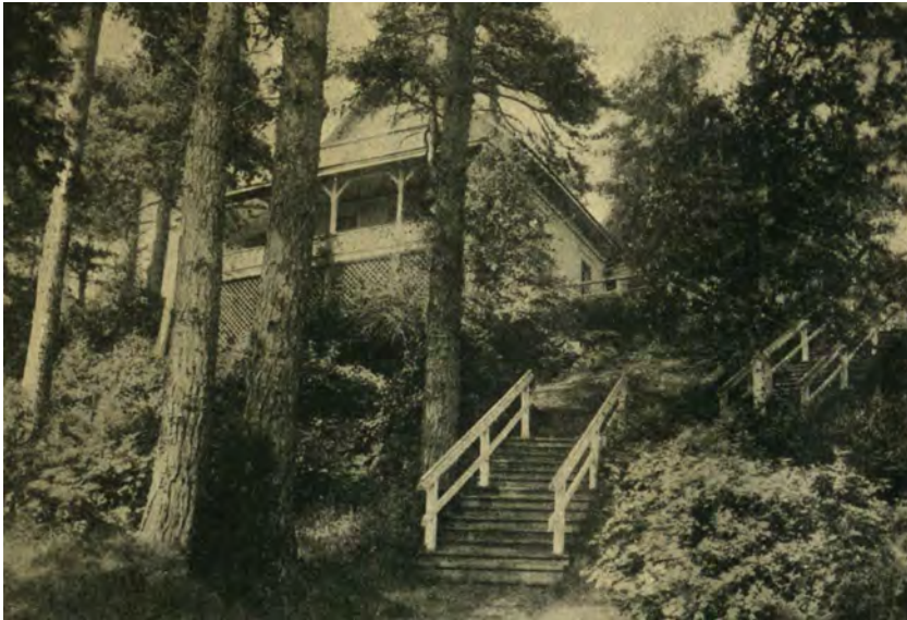
Huvila Pyhäjärven rannasta katsottuna. Portaat johtivat terassipäättyyn. Portaat on purettu myöhemmin.
