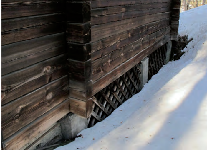
Itäjulkisivun sokkeli. Maa viettää tuulettuvaan sokkeliosaan.
