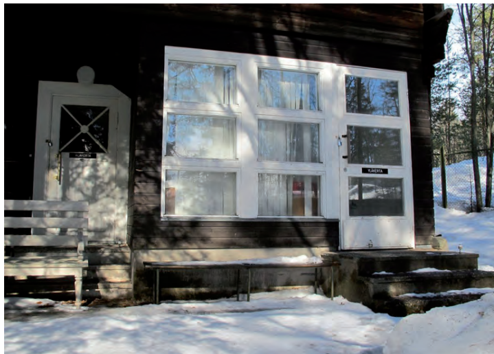
Sisäänkäynti rehtorin asuntoon tehtiin vuoden 1973 peruskorjauksen yhteydessä.
