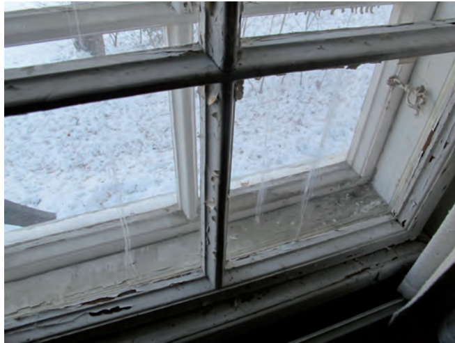
Pohjakerroksen ikkuna on kunnostettavissa.
