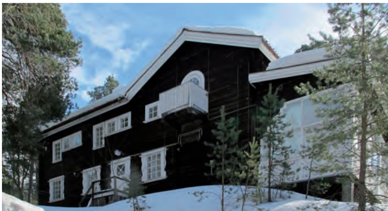
Julkisivu pohjoiseen keväällä 2011.
