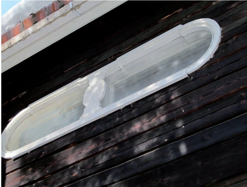
Luhtiparven aukkoihin on asennettu ikkunat.
