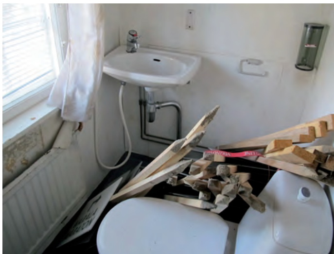
Pohjakerroksen wc-tila keväällä 2011.
