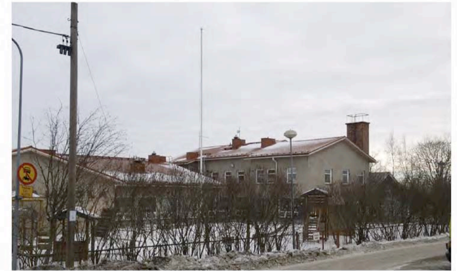
Ahjolan piha avautuu Erämiehenkadun suuntaan.
