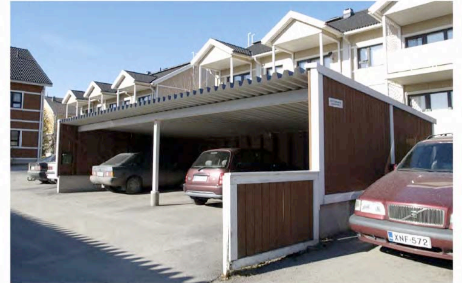
... ja autot eteläpuolelle.
