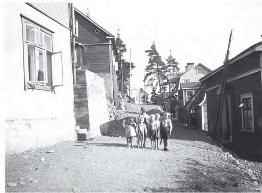
Lapsia Provastinkadun varrella. Lasten takana vasemmalla oleva talo on Vesisäiliönmäen alapuolella. Kuva Tyko Varto 8.9.1934. Vapriikin kuva-arkisto.
