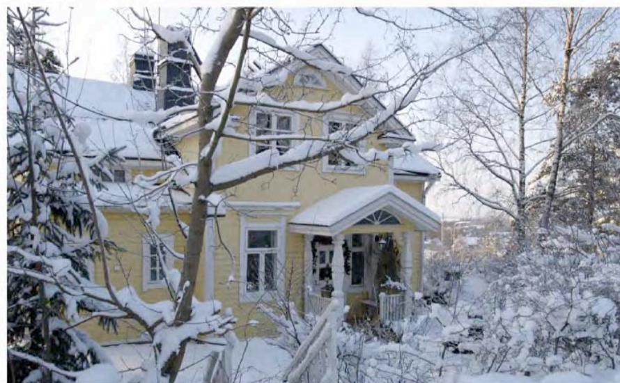
Erämiehenkadun päässä on Pispalan vanha postitalo, johon on johtanut tie suoraan Pispalan valtatieltä.
