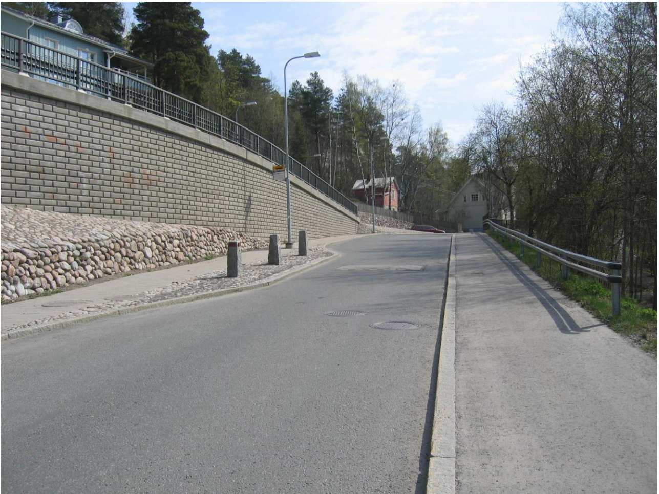
Kuva 2.4. Tulo Tahmelan viertotien ja Kannaksenkadun liittymään Tahmelan viertotietä pitkin lännestä.
