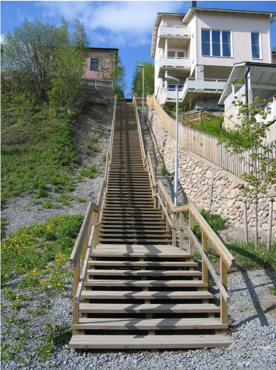
Kuva 3.4. Portaat Mäkikadun ja Rinnekadun välissä.
