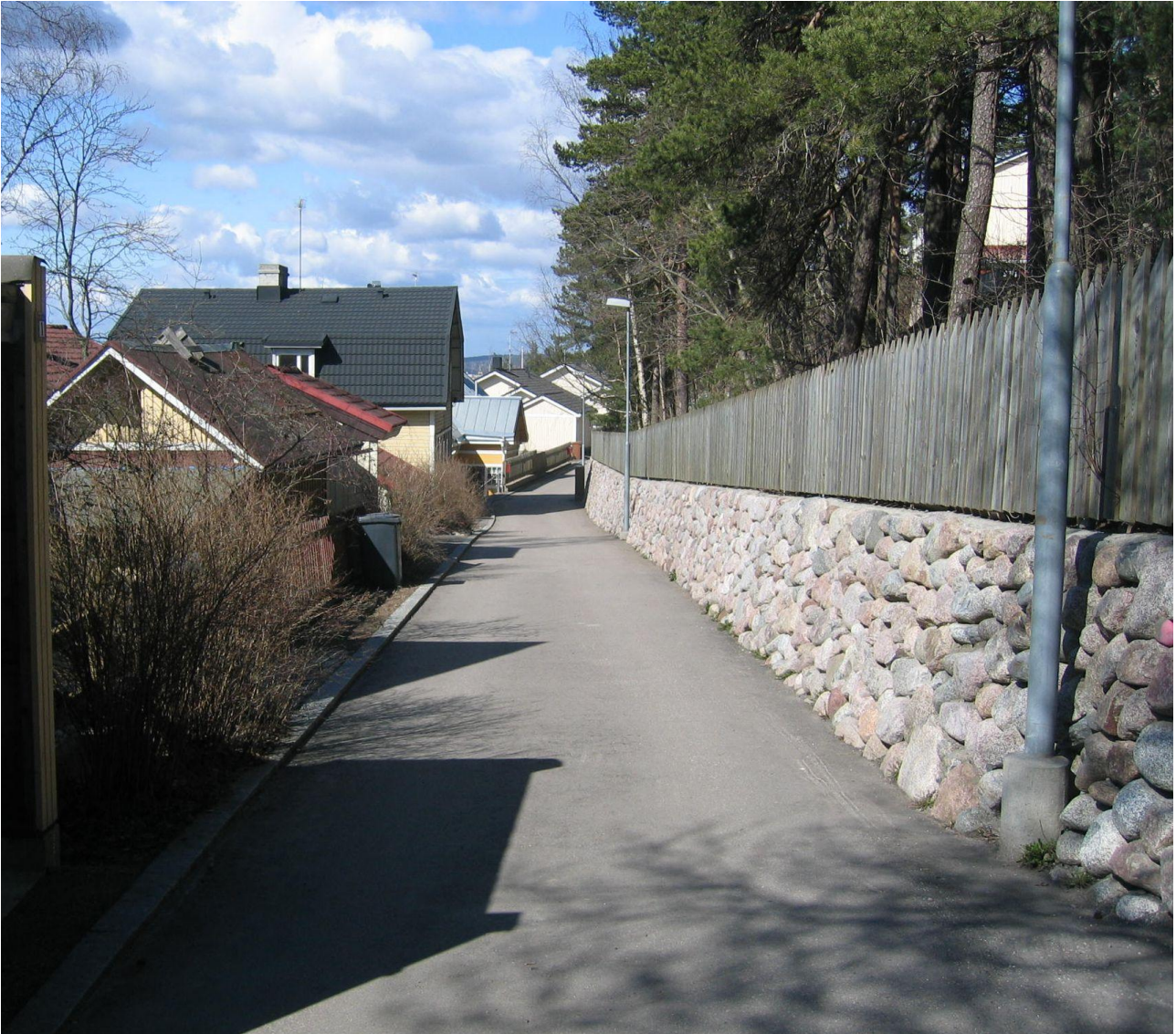
Kuva 2.3. Kapea Provastinkatu tukimuureineen.
