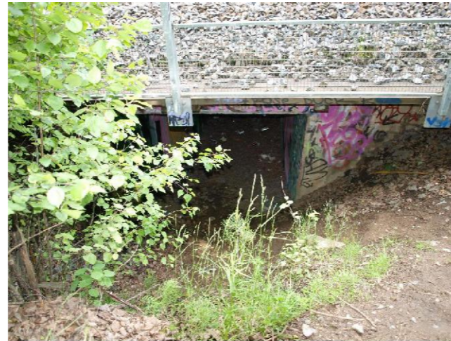
Kuva10. Pispalan kirkon alikäytävä
