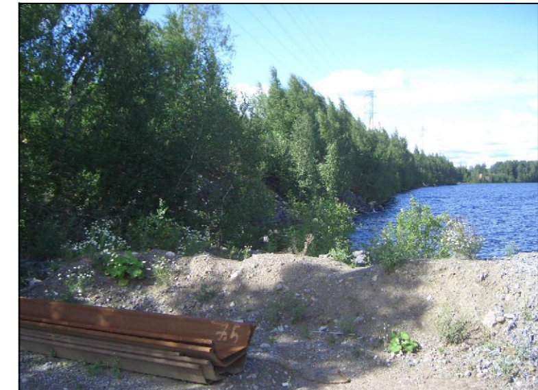
Kuva22. Näkymä uittotunnelin suuaukolta Lielahden suuntaan.
