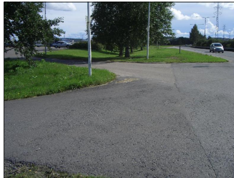
Kuva12. Näkymä satama-alueen läntisen liittymän kohdalla. Liittymäalueella liikkuu sekä satamasta poistuvia että satamaan saapuvia ajoneuvoja.
