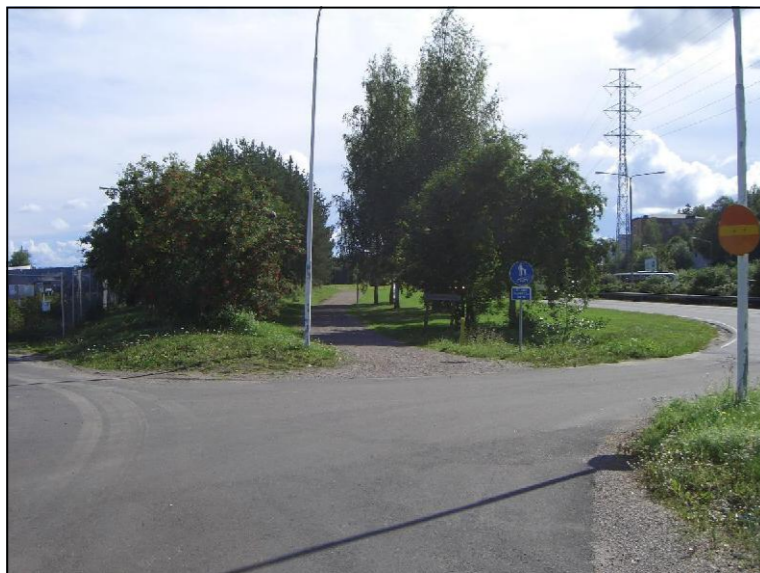
Kuva10. Kevyt liikenne risteää yllättäin Paasikiventieltä satama-alueelle kääntyvien ajoneuvojen kanssa. Samassa pisteessä myös nykyisen kevyen liikenteen väylän päättyy.
