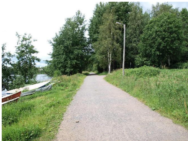
Kuva23. Väylä kuvattuna Isolähteenkadun päästä
