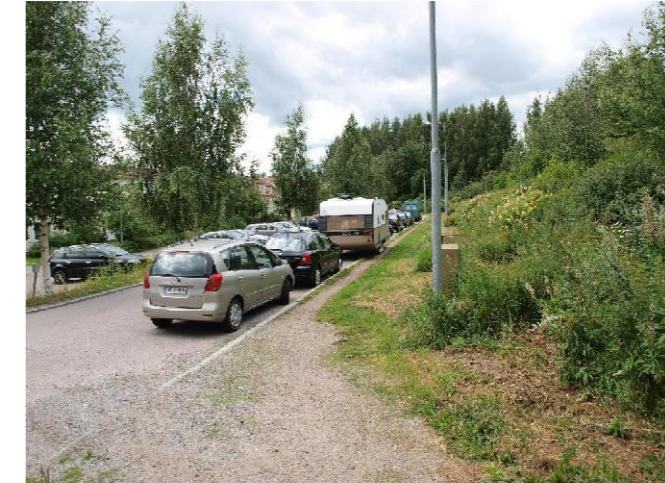
Kuva43. Näkymä Villilänkadun päästä länteen
