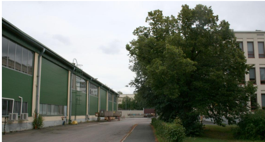
Kantatehtaan eteläjulkisivua ja liittyminen englantilaisen puiston ja hallintorakennuksen muodostamaan miljöölliseen kokonaisuuteen.
