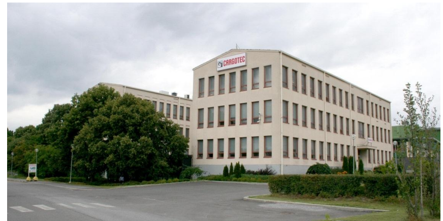
Hallintorakennus kaakosta kuvattuna.
