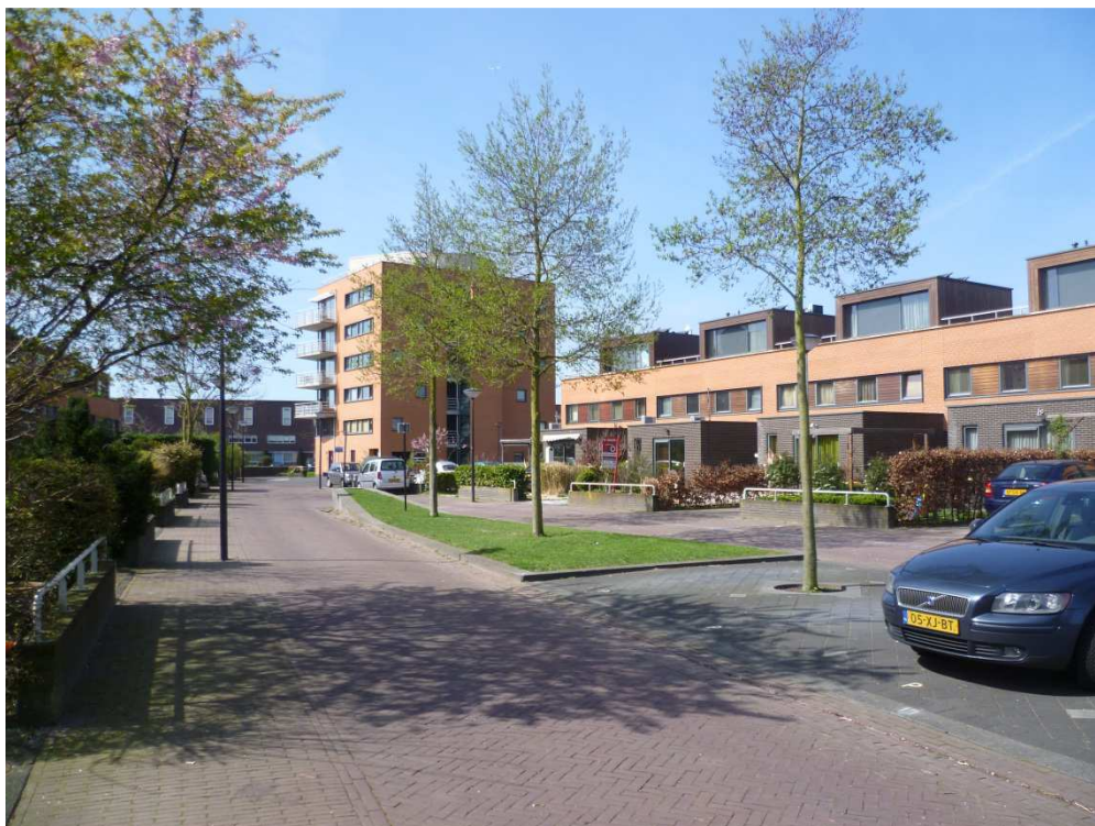
Kuva 21. Kuvaesimerkki katujärjestelyistä, jossa ajoyhteys molemmilla reunoilla ja pysäköinti/ viheralue keskellä. Viheralue toimii niin lumenkasausspaikkana kuin hulevesipainanteena. Hollanti. Kuva: Laura Soosalu
