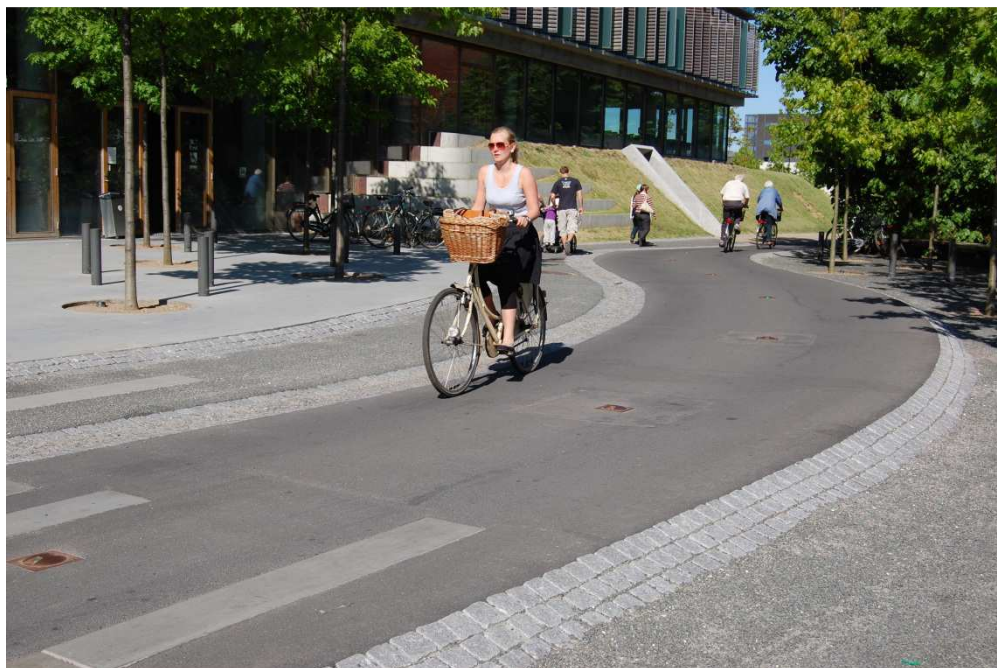
Kuva 23. Pyöräilijöille on varattu erillinen kaksisuuntainen väylä. Jalankulku on molemmin puolin pyöräväylää. Kööpenhamina Kuva: Laura Soosalu
