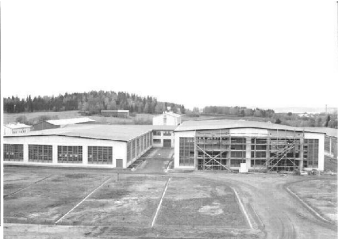
KUVA 9 Kantatehtaan sakarat valmistumassa. Kuva lännestä 1936.
