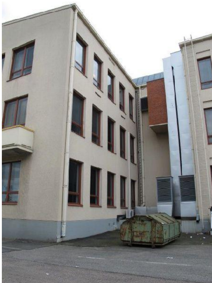
KUVA 7 Pohjoissivulta. Jälkeenpäin lisätty hissikuilu. Vasemmalla näkyvä parveke alkuperäinen. Anna Lyyra-Seppänen 5.6.2012
