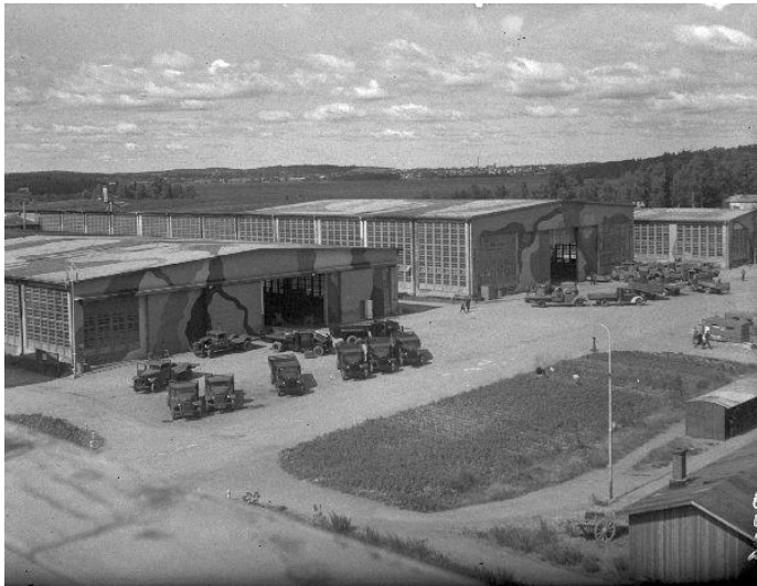
KUVA 10 Kantatehdas jatkosodan aikaisessa naamiomaalauksessa. Sakaroita on pidennetty, päädyissä ikkunapintojen tilalla liukuovet. Kuva kaakosta, 1944/1945. Vapriikin kuva-arkisto
