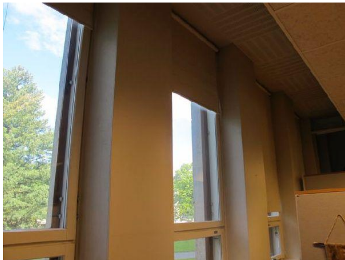
Ikkunaseinän rytmiä ja laskettu katto. Toimistohuone länsisiiven sivulla, 1. kerros. Anna Lyyra-Seppänen 5.6.2012
