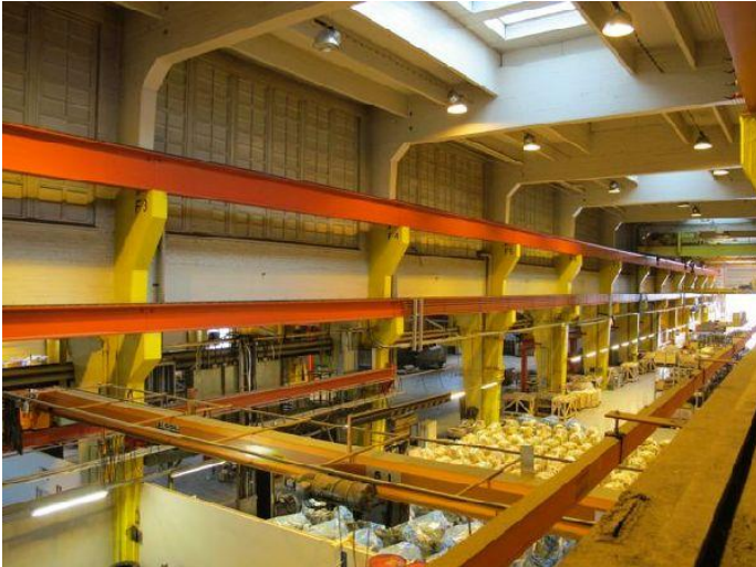
KUVA 2 Näkymä ylätasolta F-halliin.
