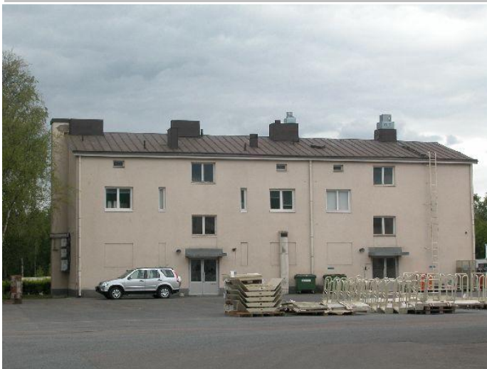
Rakennus pohjoisesta, tehdaspihan puolelta. Anna Lyyra-Seppänen 31.05.2012 16:24:00
