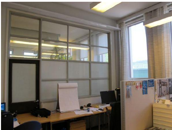
Alkuperäinen lasiväliseinä toimistuhuoneesta avotoimistoon, länsisiipi 3. kerros. Anna Lyyra-Seppänen 5.6.2012
