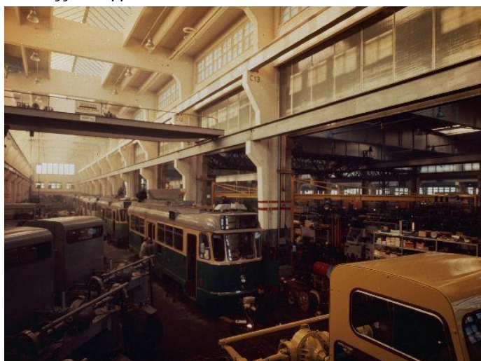
KUVA 11 Raitiovaunun valmistusta C-hallissa, ilmeisesti 1960-luvulla. Vapriikin kuva-arkisto
