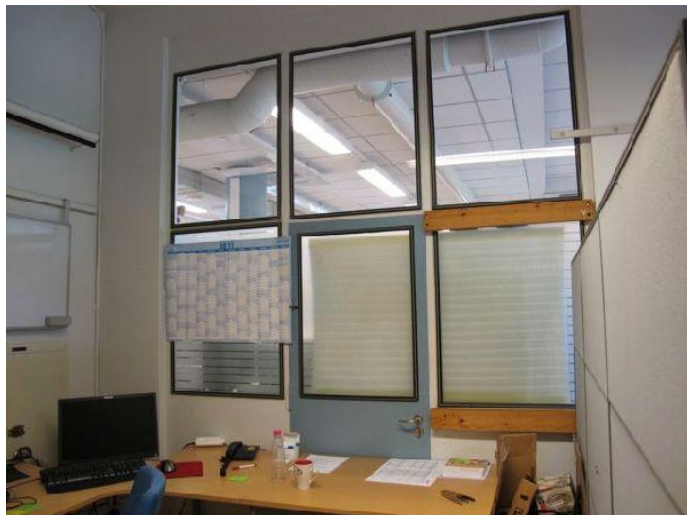
Alkuperäinen lasiväliseinä toimistuhuoneesta avotoimistoon, länsisiipi 2. kerros. Anna Lyyra-Seppänen 5.6.2012
