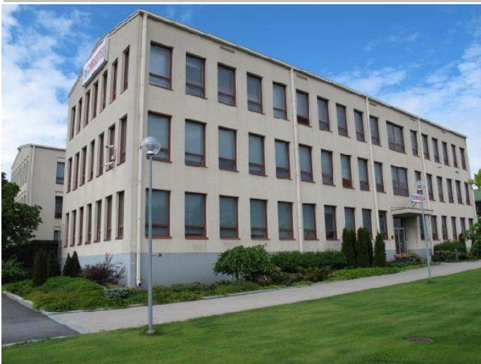
KUVA 1 Rakennus kaakkoiskulmasta. Anna Lyyra-Seppänen 05.06.2012 12:42:48
