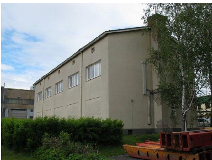
Rakennuksen itäpääty. Anna Lyyra-Seppänen 5.6.2012
