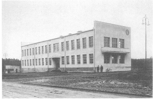
Hallintorakennus alkuperäisessä muodossaan 1936. Pääsisäänkäynti ja toisen kerroksen parvekenäköala korostuvat. KUVA Kanninen, teoksesta Mäkinen 1987.
