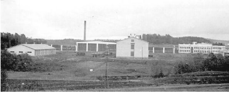
Vastavalmistunut tehdasalue lännestä. Etualalla puolustushallinnon rakennuksia. KUVA Vapriikin kuva-arkisto.
