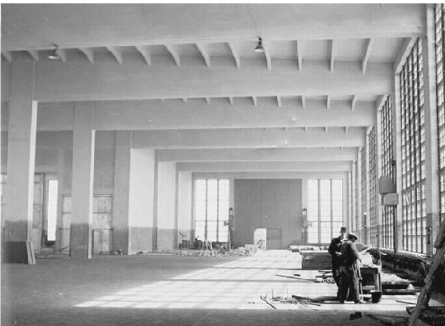
Plastiset kattopalkit leimaavat kantatehtaan muotoja. Viilaamo rakennusvaiheessa. KUVA Vapriikin kuva-arkisto.
