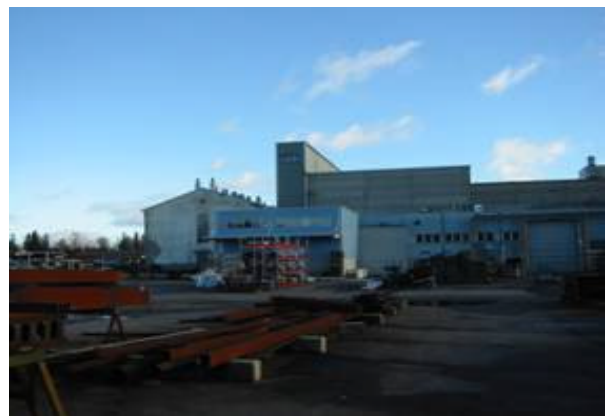
Kuva 2 - Tehdas teräspihaan puolelta, vasemmalla vanha hissitehdas
