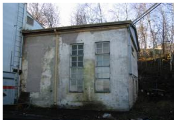
Kuva 3 - Osa rakennuksen vanhinta osaa
