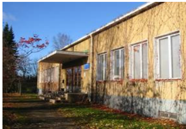
Kuva 1 - Matalan osan julkisivua
