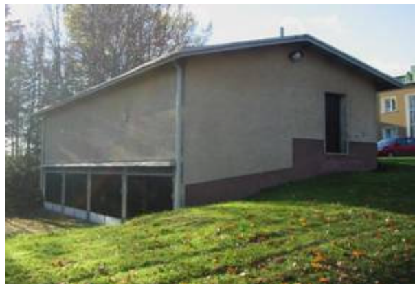
Kuva 3 - Autotalli- ja varastorakennus
