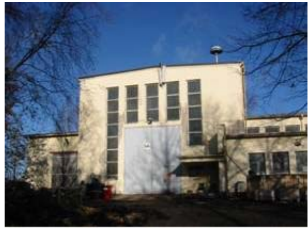
Eteläjulkisivu, vanhin osa. Lähde: Arkkitehtikonttori Petri Pussinen Oy
