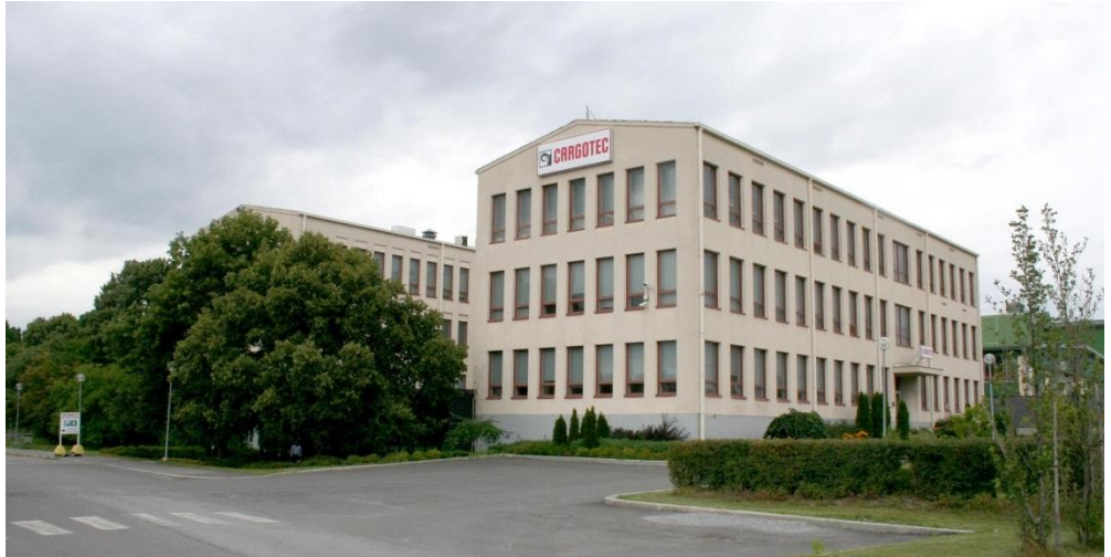
Hallintorakennus kaakosta kuvattuna.
