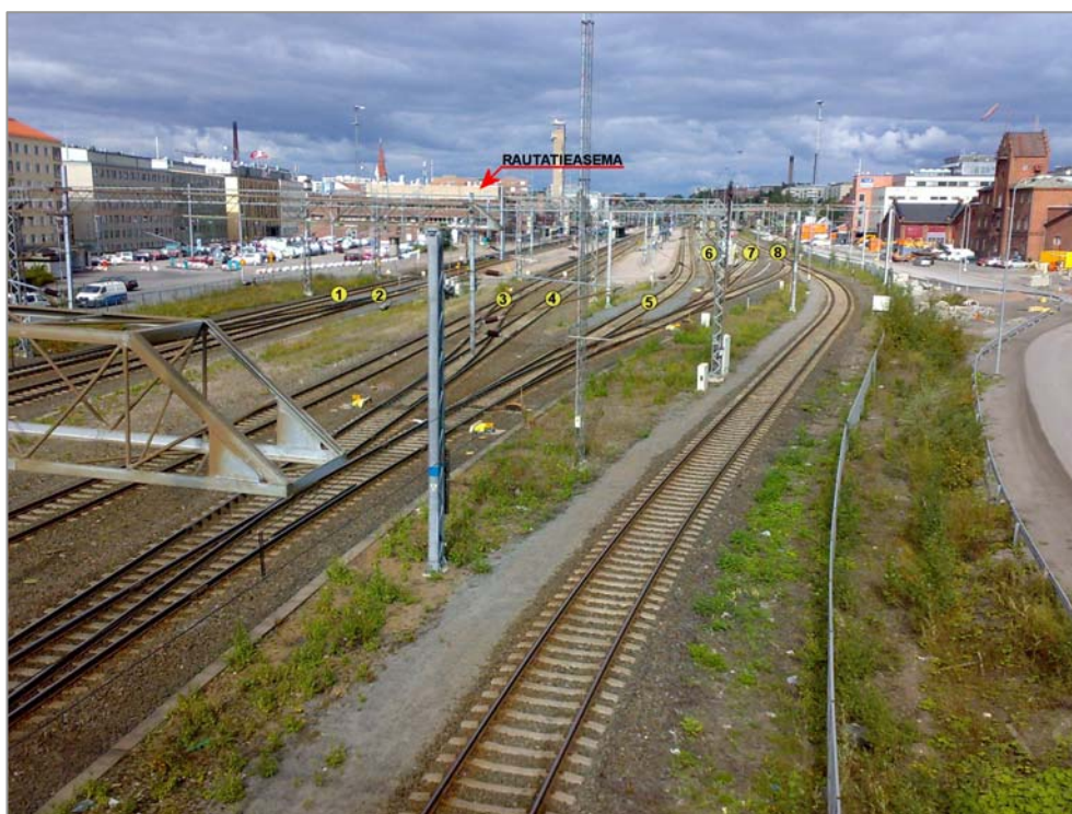
Kuva 4: Näkymä Sorin ylikulkusillalta pohjoiseen Seinäjoen suuntaan. Raitteet numeroitu raiteistokaaviosta 4021-030-516-I-3/4 saadun tiedon mukaisesti.
