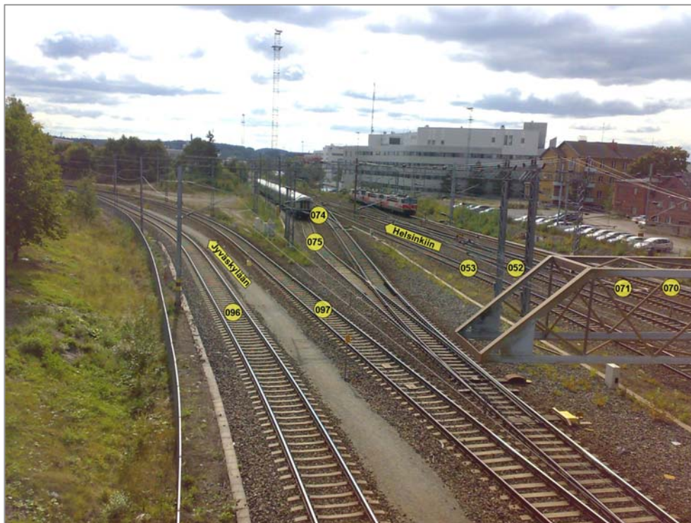
Kuva 3: Näkymä Sorin ylikulkusillalta etelään Helsingin suuntaan. Raitteet numeroitu raiteistokaaviosta 4021-030-516-I-3/4 saadun tiedon mukaisesti.
