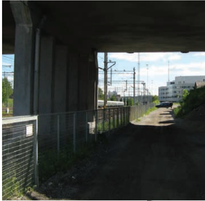
Kalevantien sillan alta etelään
