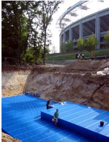
Kuva 5. Hulevesikasettien asennustöitä (wavin Q-bic, Aco Stormtank)
