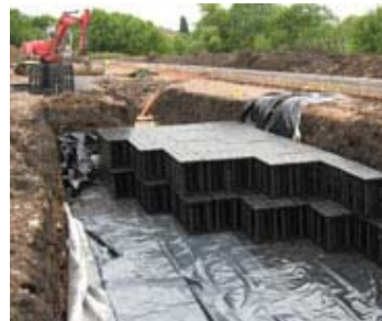
Kuva 5. Hulevesikasettien asennustöitä (wavin Q-bic, Aco Stormtank)
