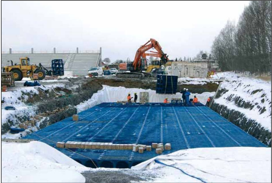
Kuva 8. Kennomainen viivytyrakenne (Wavin Qbic)
