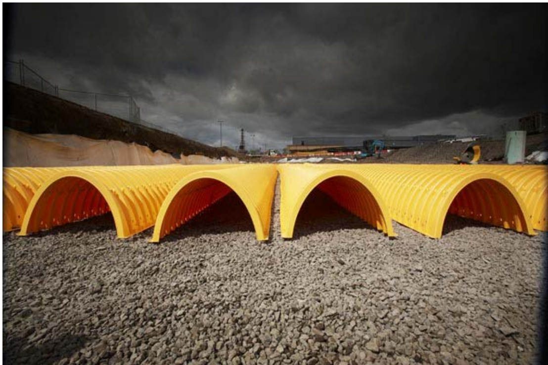
Kuva 7. Kanavamainen viivytysrakenne (StormTech)
