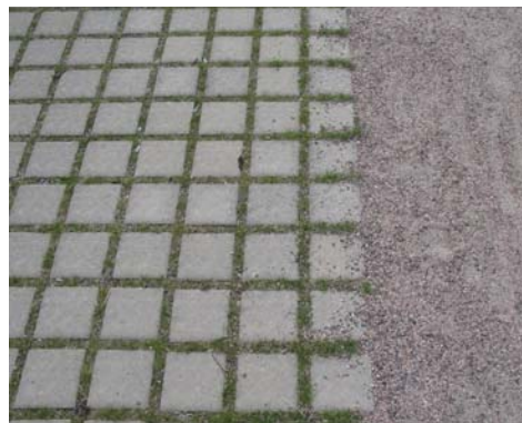
Pintamateriaaleina suositetaan vettä läpäiseviä materiaaleja. Kuvassa nurmikiveystä.
