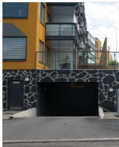
Esimerkki pihakannen alla olevan pysäköintilaitoksen sisäänajosta.
